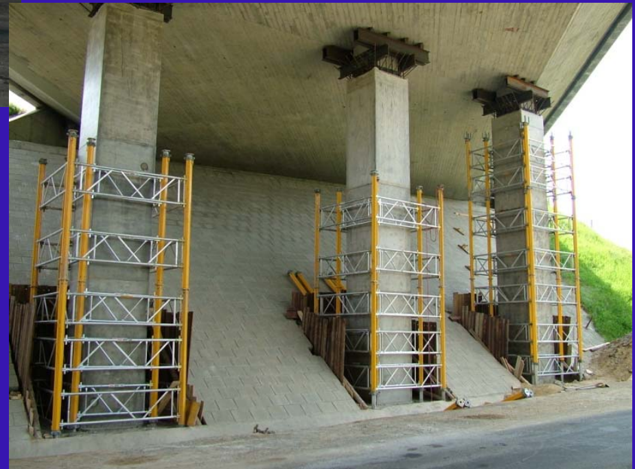
M0 útgyűrű 2.06 jelű híd
