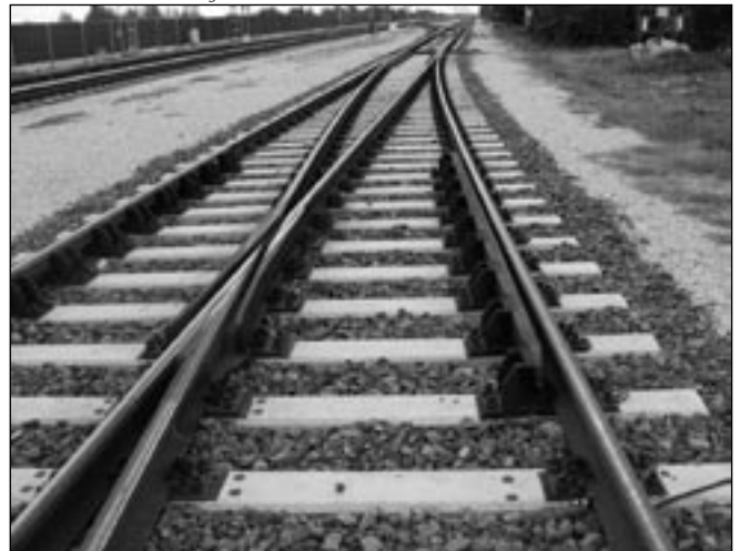
2. ábra: Vasbetonalkajra fektetett kiterő a MÁV vonalán
