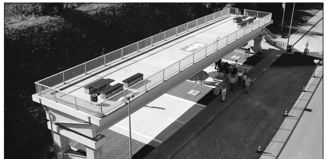
5. ábra: A bejárható Hesseler-műemlékhíd a Vellern-Süd pihenőhelyen (Foto: www.strassen.nrw.de)
