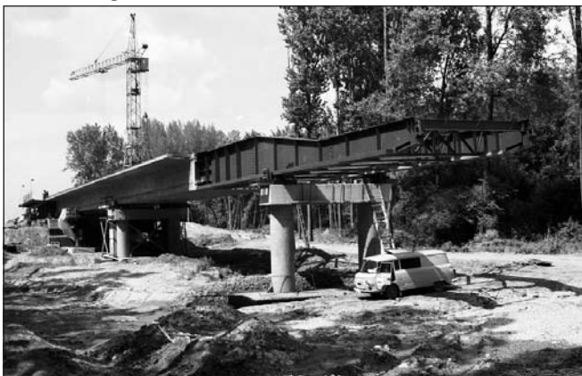
1. ábra: A cigándi Tisza-híd betolás közben
