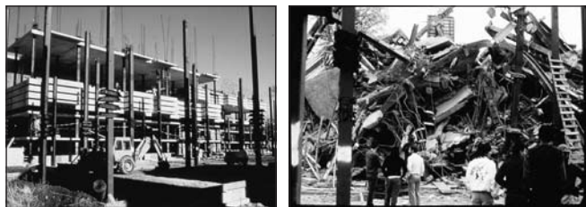
15. ábra: L'Ambiance Plaza, Bridgeport, Conn. Teljes összeomlás
