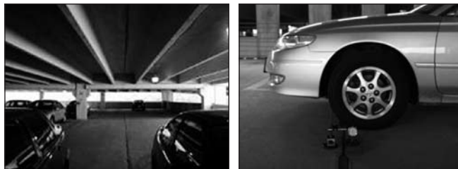
19.a,b ábrák: Parkoló épület, Holyoke, Mass. Túlzott deformáció (lehajlás)
