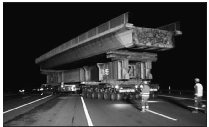
3. ábra: A Beckumi Hesseler-műemlék-híd áttelepítése (© www.eautobahn.de)
