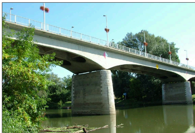
4. ábra: A sárospataki Bodrog-híd
