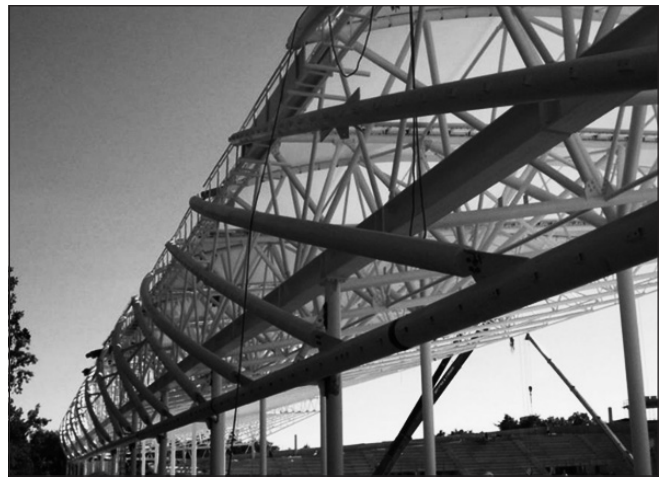
13. ábra: Homlokzati csőívek a tetőszerkezettel
