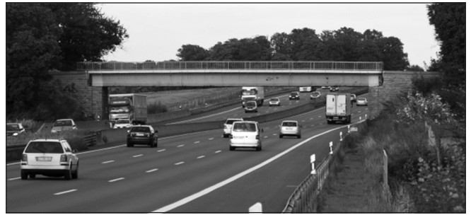
2. ábra: A világ első feszített betonhidja az A2-es autópályán (© Elke Wetzig (CC-BY-SA))
