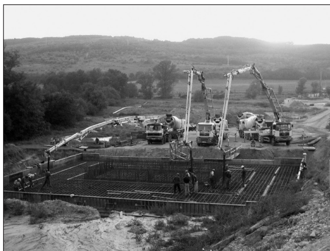
5. ábra: 1600 m 3 -es cölöpösszefogó gerenda építése
