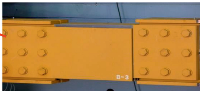
A csillapítóban elhelyezett vertikális acellemezek egymásközi relatív elmozdulását a viszkoelasztikus anyag gátolja, tehát csillapít
