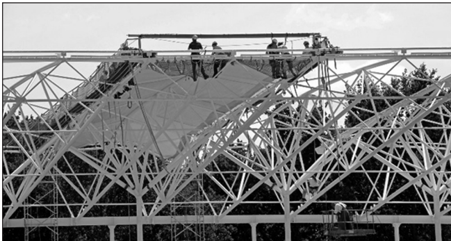
12. ábra: Membrán héjazat szerelése
