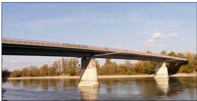
9. ábra: A tahitótfalui Tildy Zoltán Szentendrei-Duna-híd
