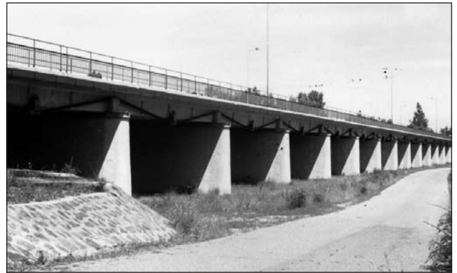
2. ábra: A szolnoki árteri „százlábú” Tisza-híd
