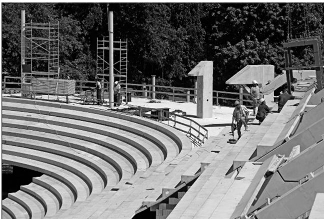
7. ábra: Íves előregyártott lelátóelemek
