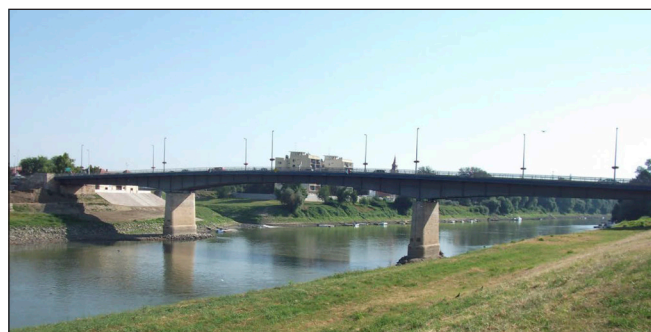
5. ábra: A szolnoki Tisza-híd
