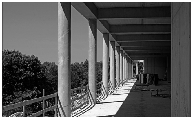
5. ábra: Előregyártott pillér-gerenda váz, takart csomópontokkal
