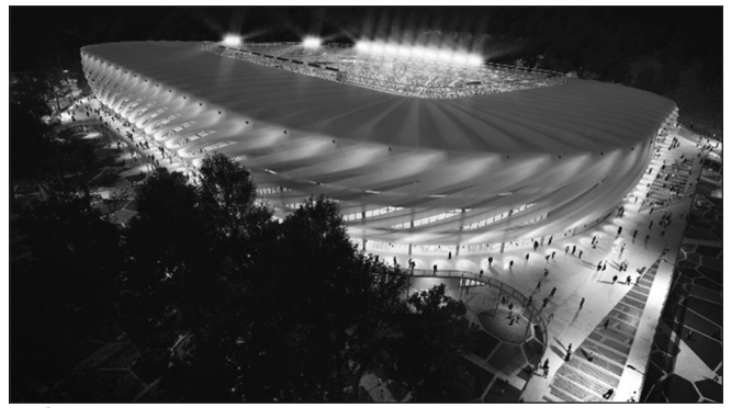
3. ábra: Nagyerdei Stadion a levegőben vezetett járdával
