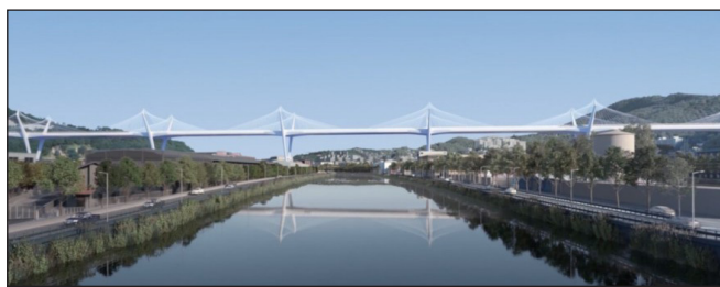
20. ábra: Ponte dei pescatori – Image © Santiago Calatrava
