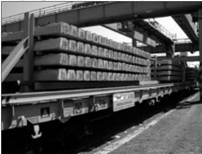
1. ábra: Az LW betonalkaj szállítása a Lábatlani Vasbetonipari Zrt. telephelyéről a gyorsátépítő speciális szállító szerelvényén
