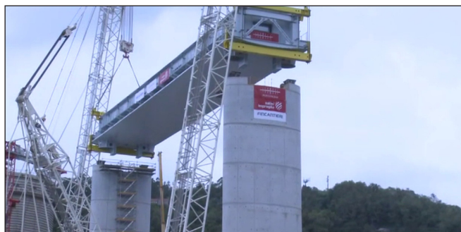
6. ábra: Az épülő új viadukt első darabja
