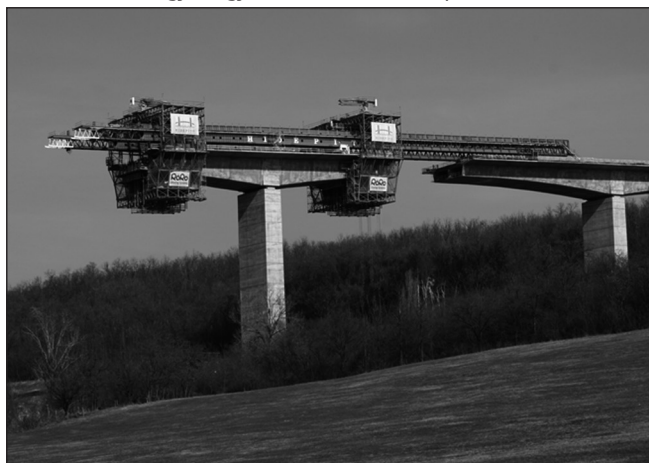
6. ábra: Kőröshegyi völgyhíd felszerkezetének építése
