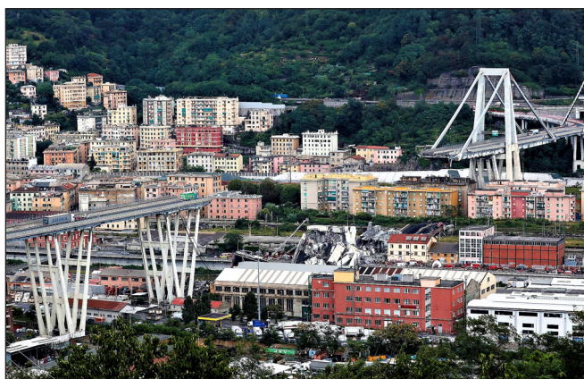
1. ábra: A Morandi híd az összeomlás után, Genova
