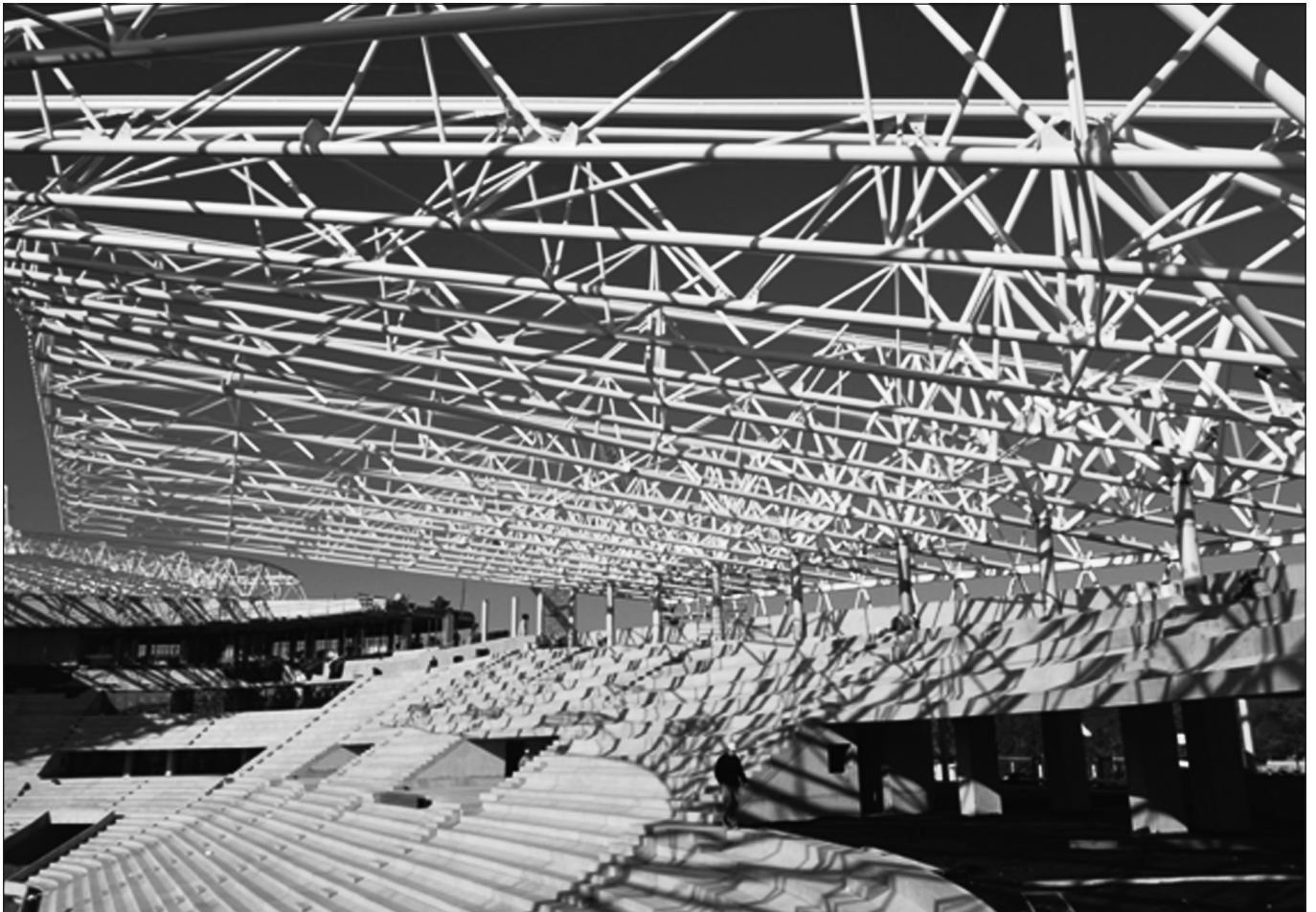
14. ábra: Rövidebb oldalak „átmeneti” tetőszerkezete szerelési állapotban
