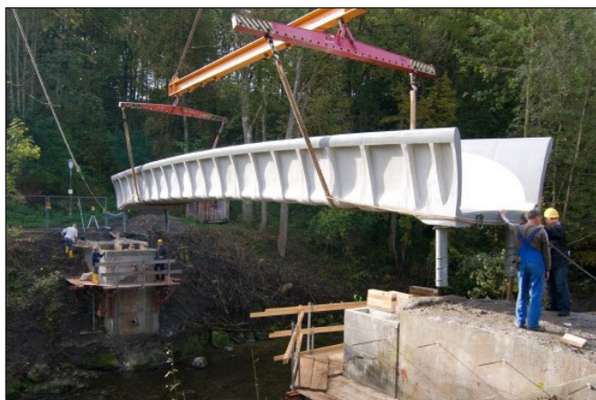
2. ábra: Karbonbeton gyalogos és kerékpáros híd beépítése Kempenben (TU Dresden)
