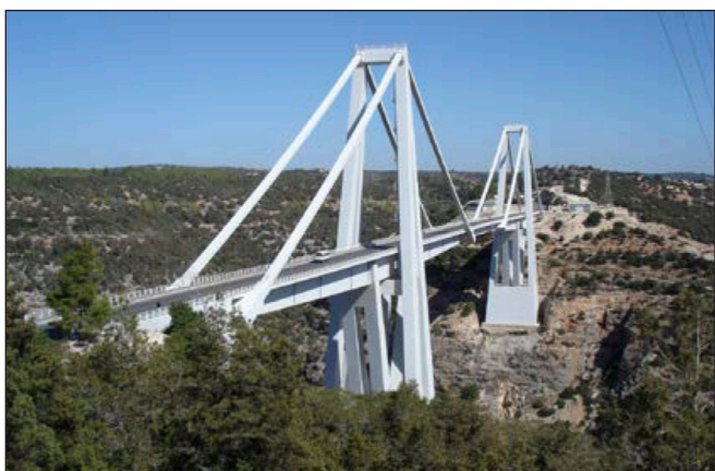
5. ábra: Morandi Wadi al Kuf viaduktja Líbiában
