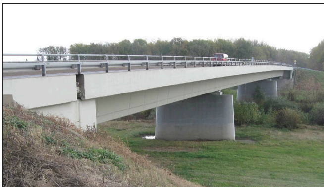
12. ábra: A berettyószentmártoni Berettyó-híd
