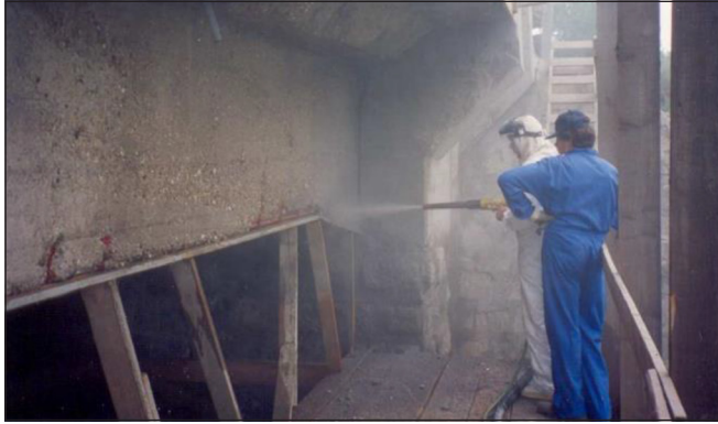
A lágymányosi Rákóczi híd pilonjainak korrózió elleni védelme
