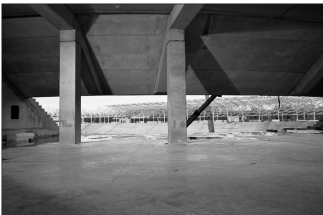
8. ábra: Alul „sík” íves előregyártott lelátóelemek
