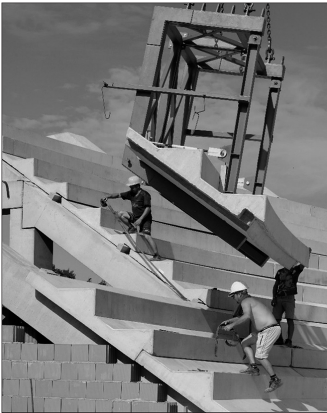
6. ábra: Alul sík előregyártott lelátóelemek
