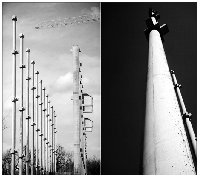
15. ábra: a: Homlokzati és belső pillérek, b: Előregyártott feszített körpillérek
