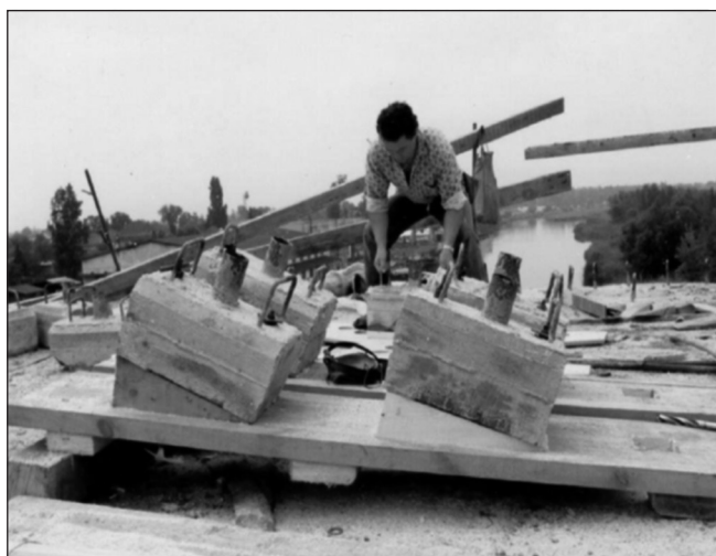
2. ábra: A feszítés lehorgonyzásaiba beépített előregyártott tömbök
