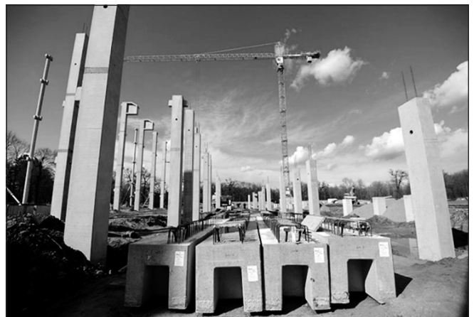
16. ábra: Előregyártott gerendák takart kapcsolati véggel
