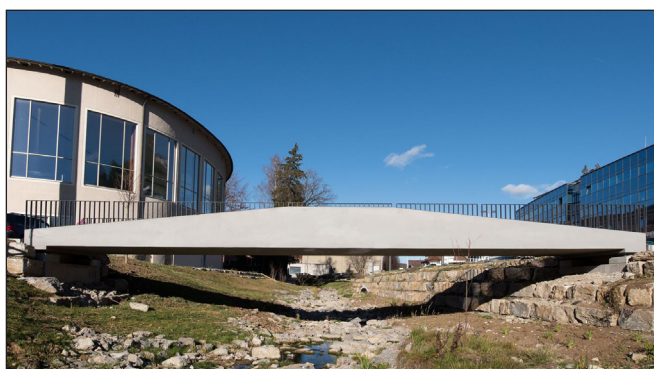
4. ábra: A világ első, csak karbonbetonból készült hídja Albstadt-Ebingenben (Solidian)
