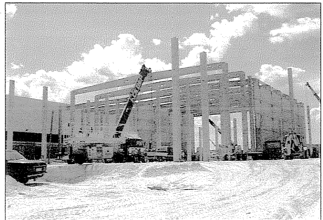
Fig. 22: LIEGL & DACHSER Structural assembly
