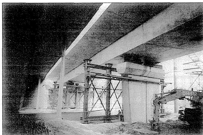
1. fénykép Az elkészült hídstruktúra
