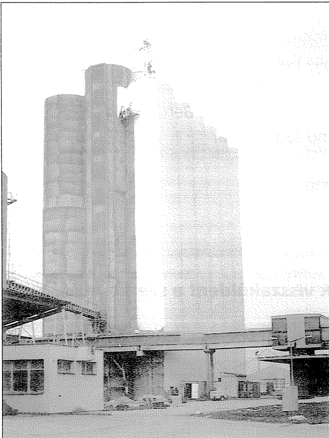
3. fénykép A déli és a keleti oldali alapozó és fedőfestése
