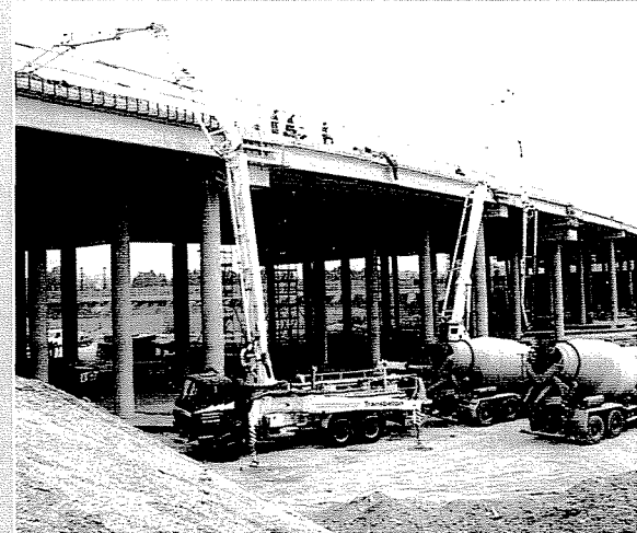
M0 autótűt Dulácska-híd építés közben
