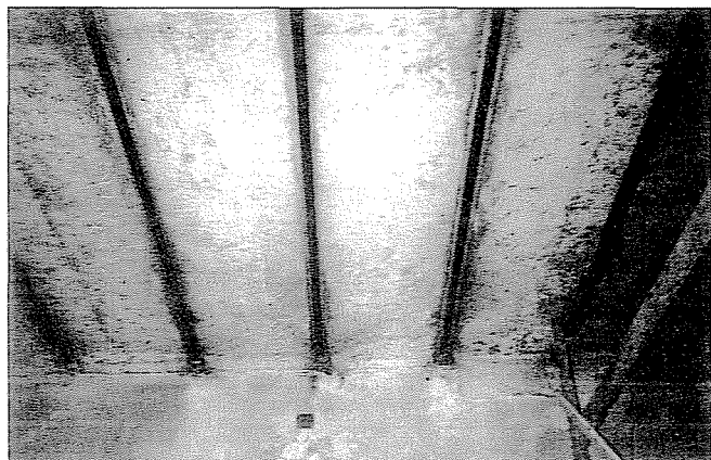
3. ábra A Budapest VII. ker. Erzsébet krt. 32. sz. épület 1. emeletén lévő zeneiskola födémének megerősítése (1996. június, megerősítő szalagok: Sika CarboDur S512-70m, tervező: Dr. Balázs L. György, kivitelező: Schöck és Tsa. Bt.)
