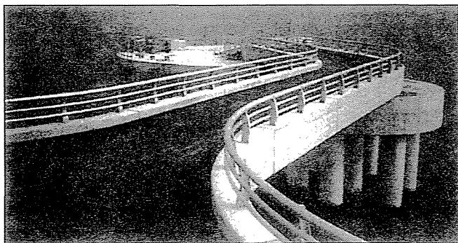
8. ábra: Híd a Haramachi hőerőmű területén, Japánban (FRP International, 1997)
