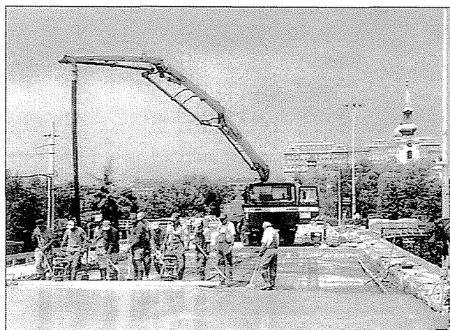
13. ábra: Vasalt útalap betonozása
