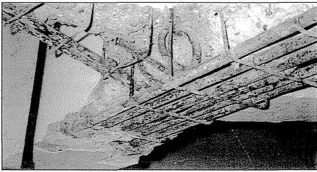
8. ábra: Főtartó keretgerenda és fiókgerenda feltárt alsó vasalása
