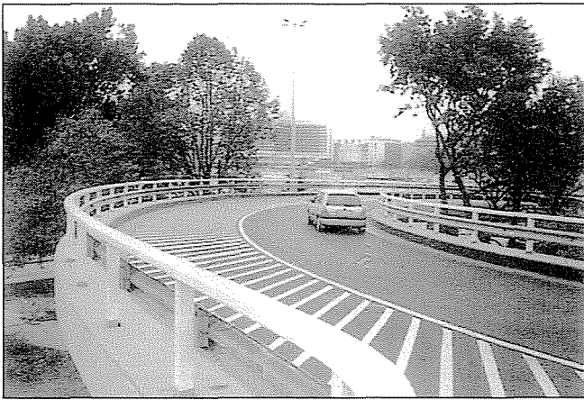
5. ábra: A felújított hídpálya
