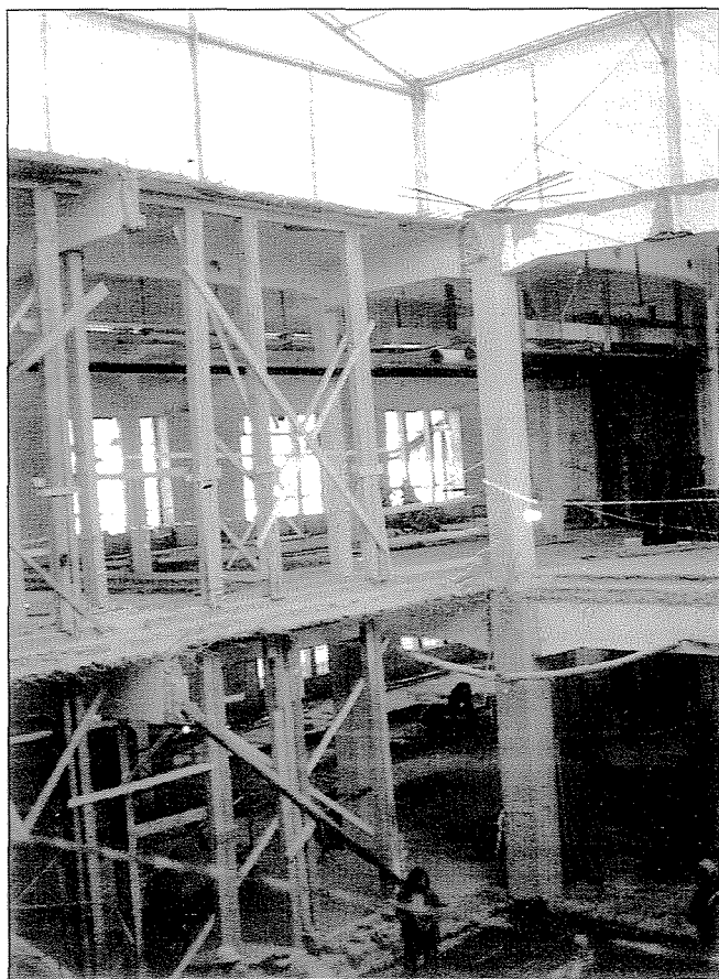
14. ábra: Az I. jelű épület belső sarkában lévő elbontott lépcsőház helye, az új kazettás födémek beépítése előtt
