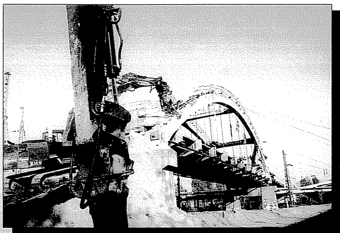
Bp. Újhegyi úti felüljáró roppantásos technológiával történő bontása
