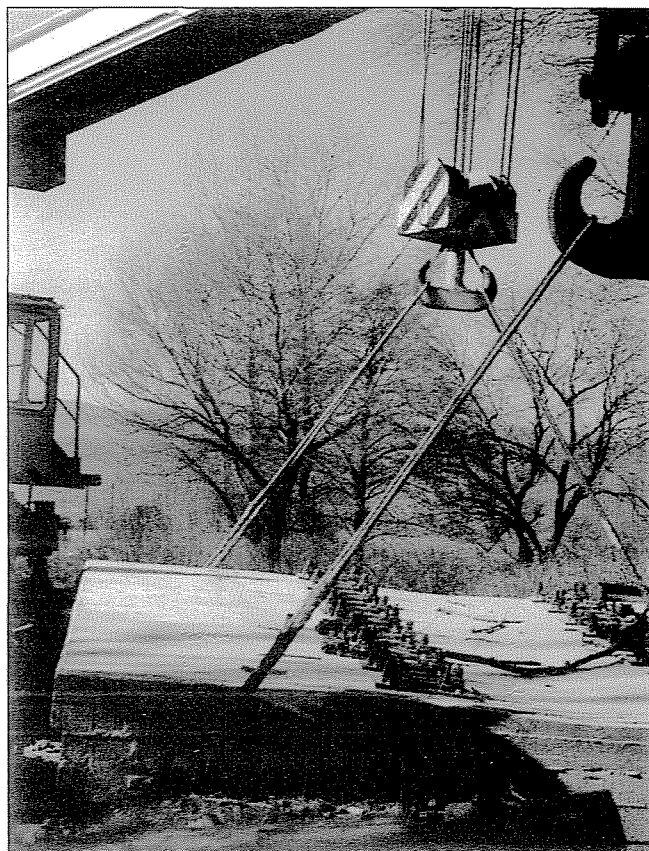
14. ábra: Közvetlen leerősítésű vasbeton lemezhid beemelése 1989-ből
