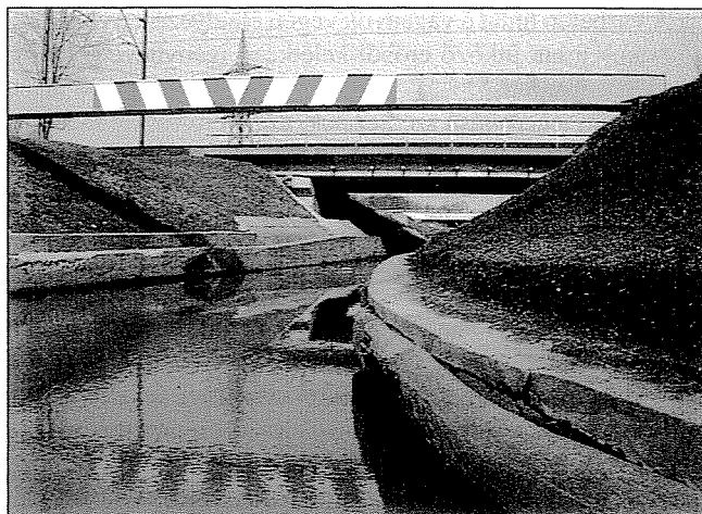
21. ábra: Védőkapuval védett patak-híd
