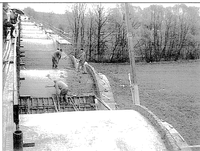
10. ábra: A boltozat megerősítés hagyományos módszerei a) Boltozat megerősítés vasbeton nyereggel (Jezernice viadukt, Csehország) b) A boltozat kiváltása vastag löttbeton kéreggel
