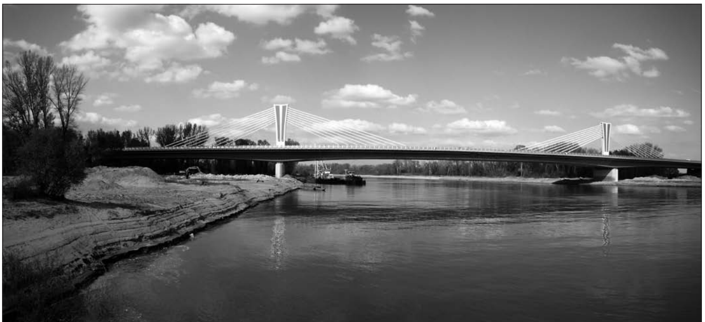
1. ábra: A Móra Ferenc-híd a Tisza felől
