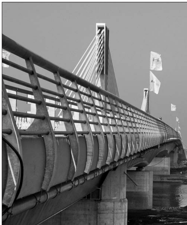
8. ábra: Átadási díszben a híd
