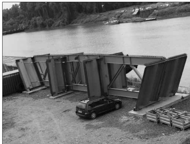
7. ábra: Beemelésre váró acélszerkezet
