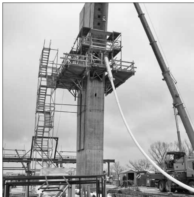
10. ábra: Kábelbefűzés
