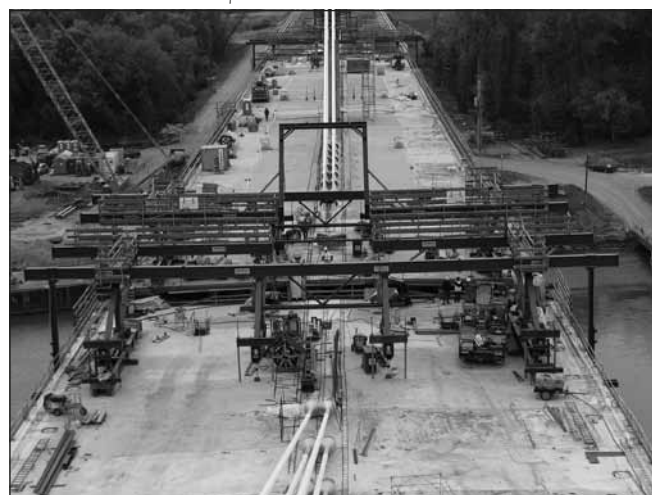
16. ábra: Mederzárás a pilonról szemlélve
