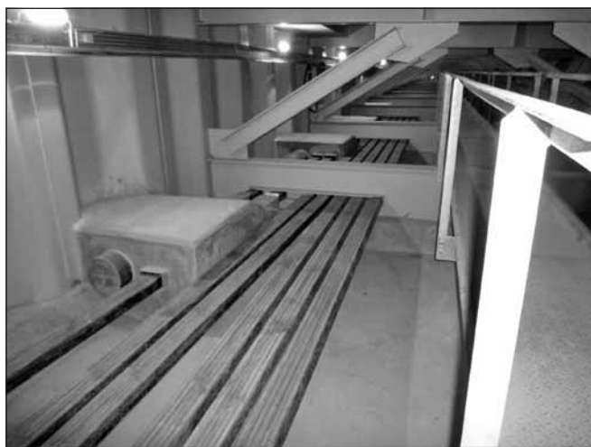
11. ábra: Szabadkábelek a lehgorgonyzó tömbökkel
