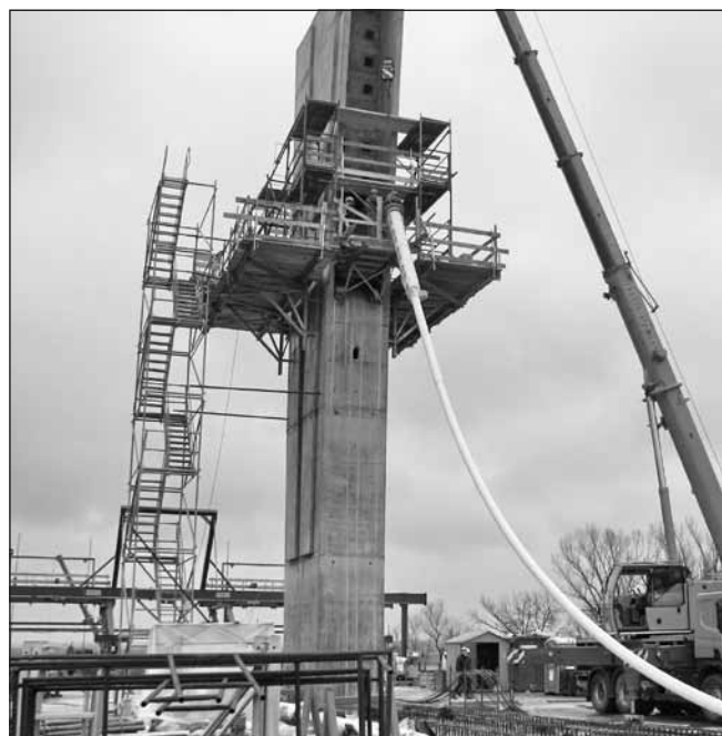
10. ábra: Kábelbefűzés
