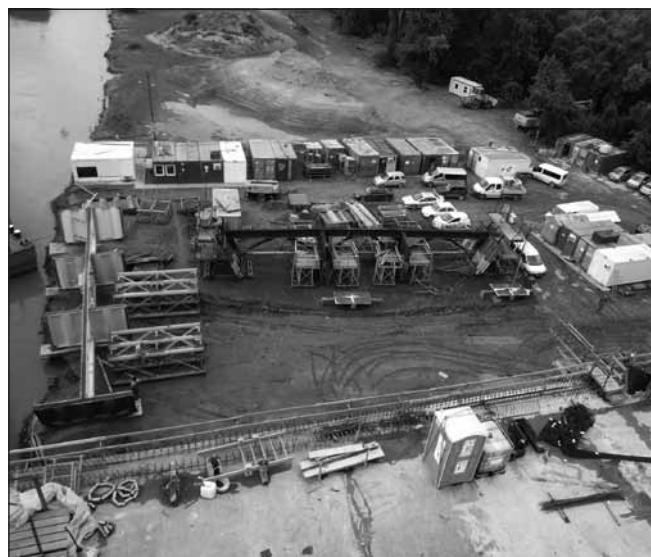
6. ábra: Az acélszerkezet összeállítópadja madártávlatból
