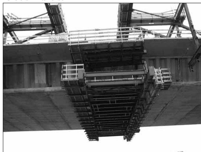
16. ábra: Mederzárás a pilonról szemlélve
