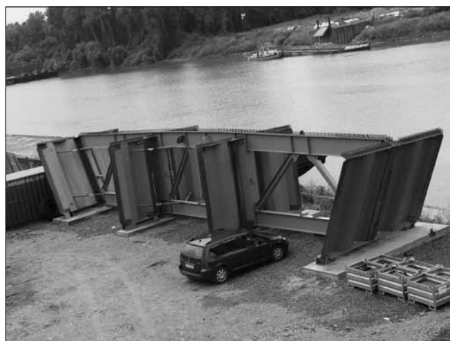
7. ábra: Beemelésre váró acélszerkezet
