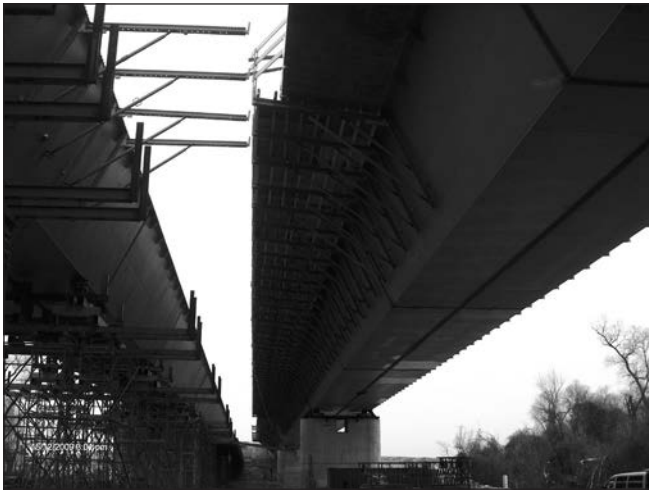
6. ábra: A bal oldalon az acélszerkezet szerelése állványon, a jobb oldalon a pályalemez betonozása járom nélkül látható.
