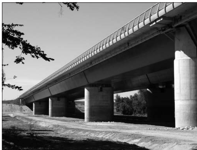
2. ábra: A négynyílású ártéri híd oldalnézete
