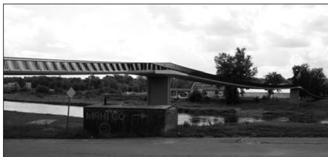
2. ábra: Gyalogos függesztett vasbeton híd a prágai Troja városrészben
