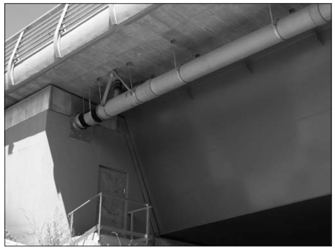
8. ábra: A HOBAS vízvezető cső átvezetése a hídfőn
