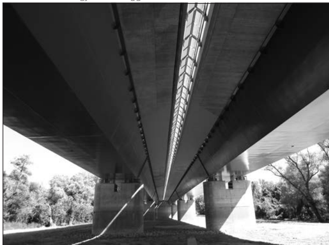
1. ábra: A két, egymástól független ártéri felszerkezete alulról
