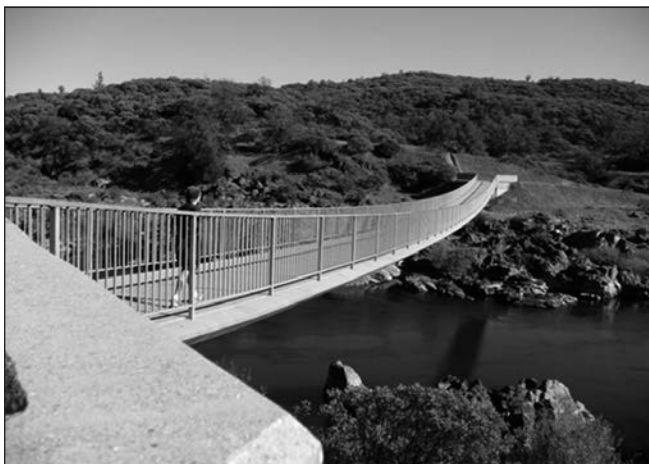
1. ábra: Feszített vasbeton szalaghíd Kaliforniában
