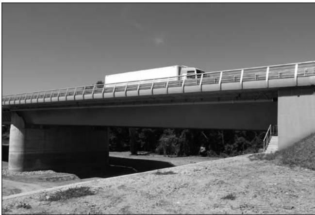
3. ábra: Az egynyílású ártéri híd oldalnézete
