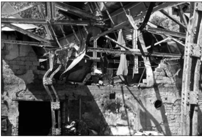
2. ábra: Tűzkárosult épület ( http://tuzfal.com/index.php?cont=cikk&cikk=26&rov=2 )
