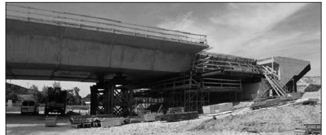
10. ábra: A DC2 hídszakasz 26-os hídfő felőli utolsó zömének gyártása függesztett zsaluzatban
