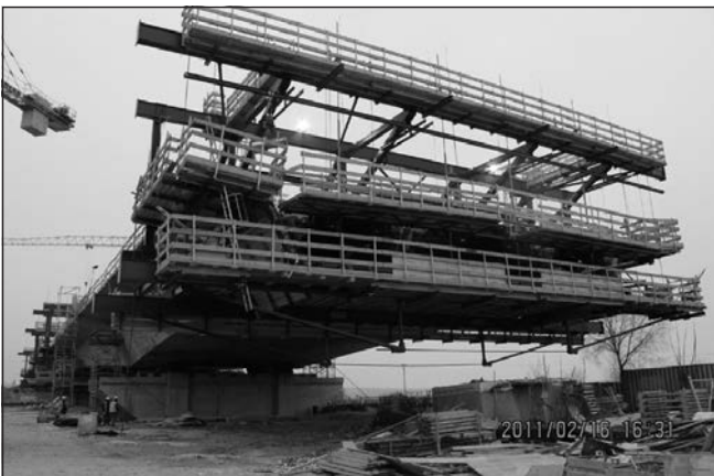
9. ábra: A DC2 hídszakasz zsaluzókocsija
