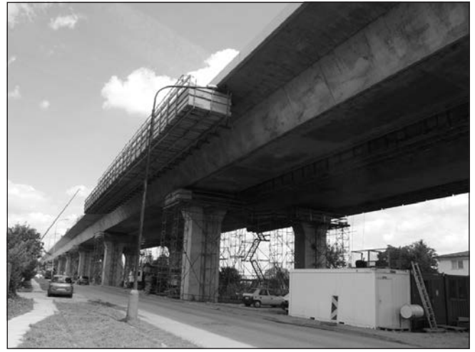
14. ábra: Befejező munkák a DC1 hídszakaszon: szegélygyártás
