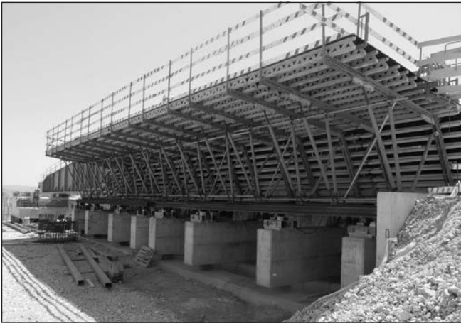
6. ábra: A DC1 hídszakasz gyártópadja, előtte az indulásra kész szerelőcsőrrel
