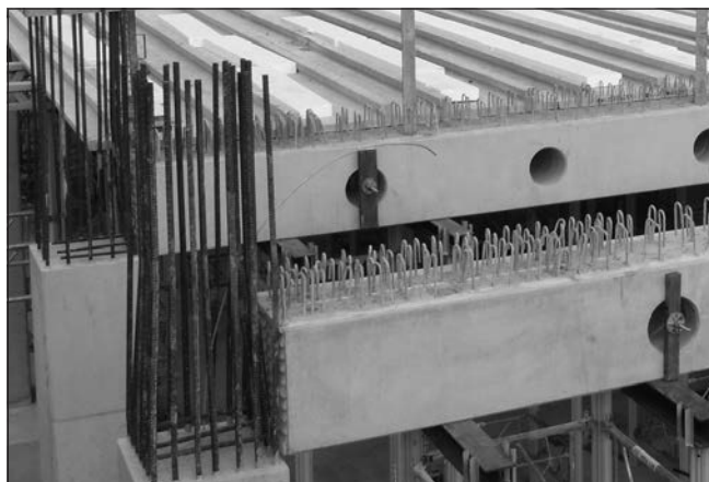
10. ábra: A panelek bordái közötti önsúlycsökkentő könnyítések
