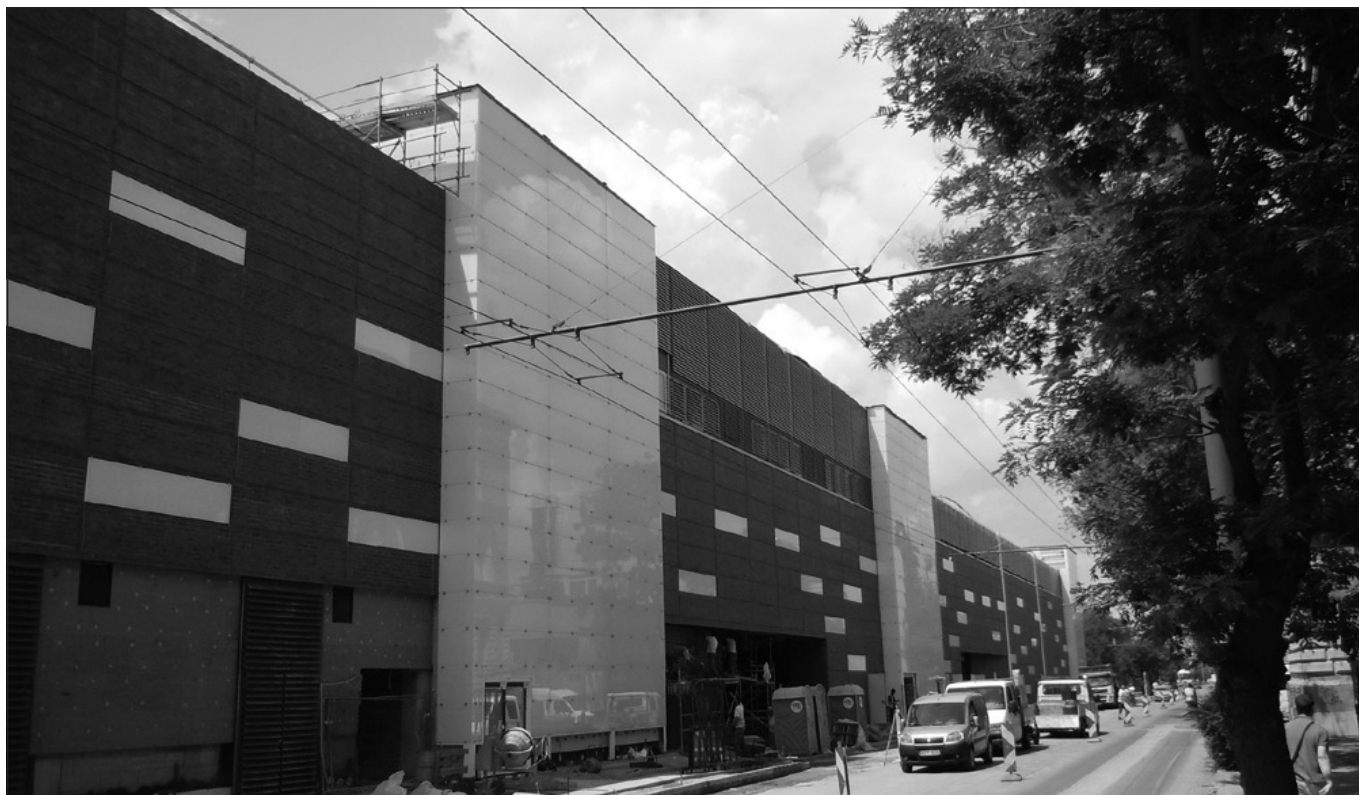
15. ábra: A homlokzat átadás előtt
