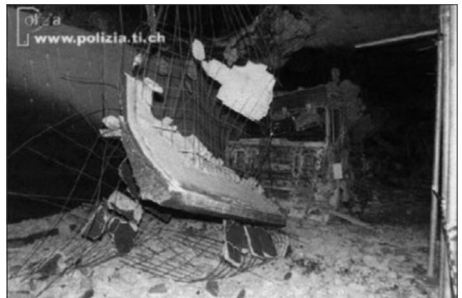
1. ábra: Gotthárd alagút betonfelületének réteges leválása (polizia.ti.ch, 2008)
