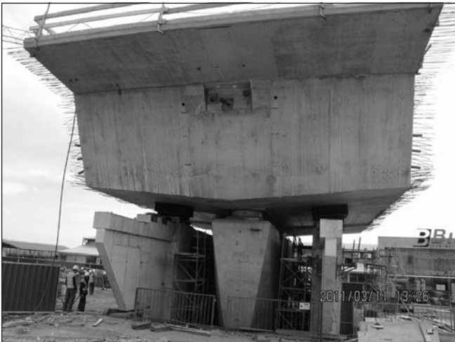
8. ábra: A stabilizáló vasbetonfalakkal alátámasztott elkészült indítózóm a keresztirányú feszítés lehorgonyzó fejeivel
