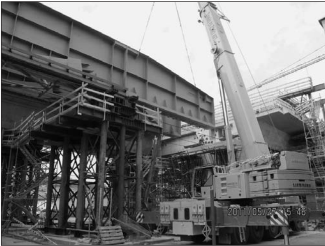
13. ábra: A DC1 hídszakasz szerelőcsőrének leszerelése darabokban a közös pillér elérése előtt
