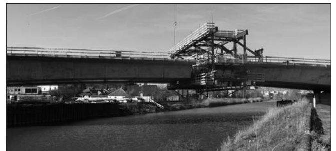
11. ábra: A DC2 hídszakasz két ágának zárása a folyó fölött
