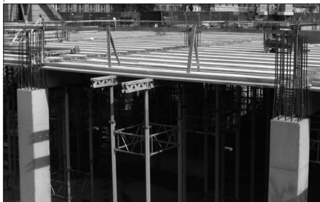
5. ábra: Födémpanel-dúcolás. Az oszlop-gerenda és födémlemez csomópont a kibetonozás előtt
