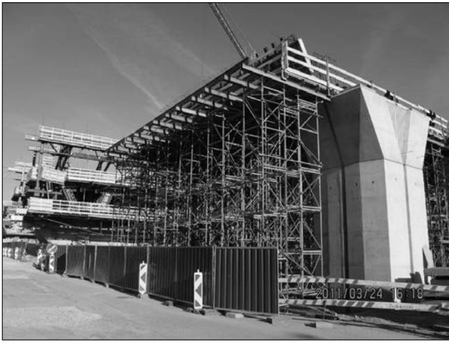
12. ábra: A DC2 hídszakasz 21-es közös pillér felőli utolsó zömének gyártása nehézállványon
