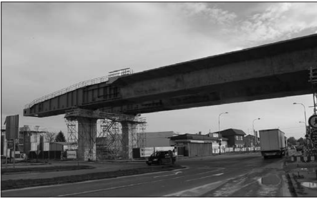
7. ábra: A DC1 hídszakasz áttolása az Érsekújvári út fölött
