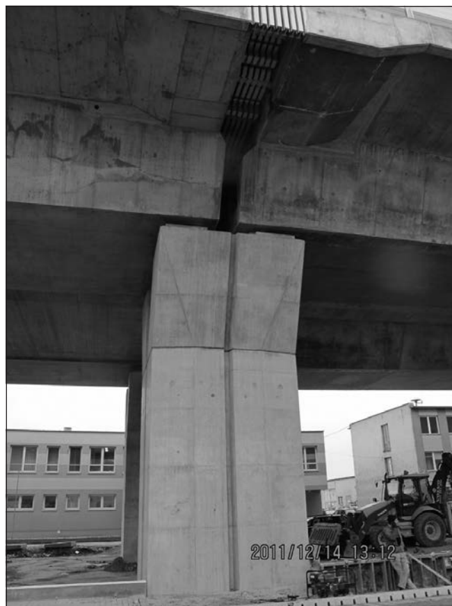
5. ábra: A 21 jelű közös pillér a dilatációs szerkezettel
