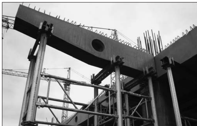
8. ábra: Előregyártott konzol aládúcolva
