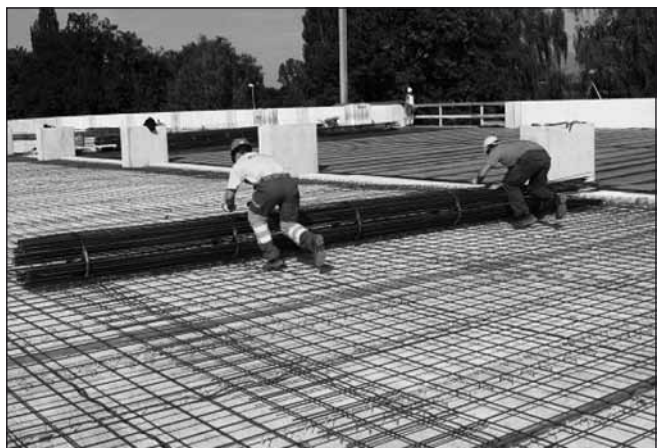
12. ábra: BAMTEC® vasalási szőnyeg kiterítése
