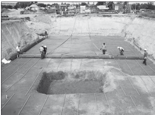
17. ábra: Vízáró medence alaplemeze, 1. réteg. vasalás terítése, 2. réteg vasalása tekercsben oldalt
