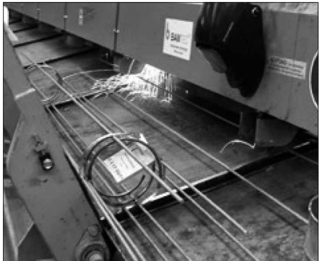
11. ábra: Automata BAMTEC® vasalási szőnyeget hegesztőgép munka közben
