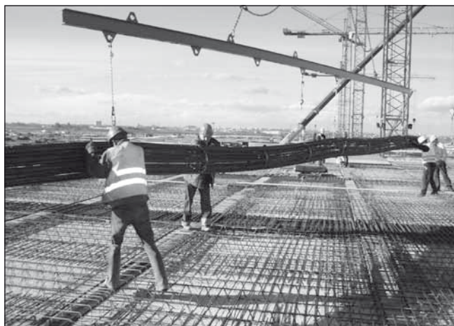
16. ábra: A 15,0 m széles szőnyegtekerccs beemelése himbával.
