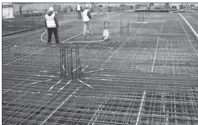
14. ábra: A kiterített szőnyegvasalások és pótvasak átszűrődés ellen
