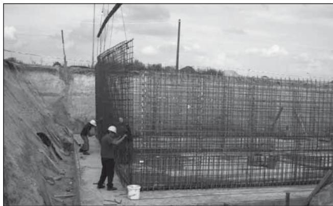
19. ábra: 2. lépés: vasalás helyére emelése daruzással
