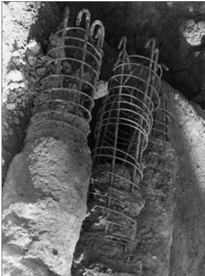
2. ábra: Fűrt cölöpök kiásás után Lőrincnél
