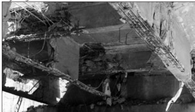
7. ábra: Az 55. sz. főút egyik törésig terhelt és robbantással gyengített hídjára még ezek után sem szakadt le
