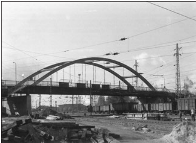
4. ábra: Szolnok szép ívhídja 1940-ben épült, 1951-ben utófeszítéssel erősítették, 1973-ban átépült
