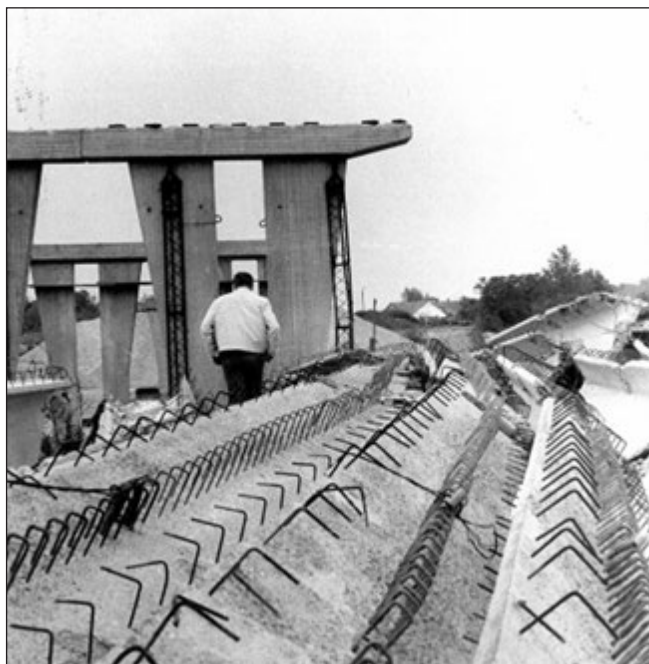
6. ábra: Az 1. sz. főút Hegyeshalom mellett épült hídjánál az előregyártott tartók beemelésekor baleset történt
