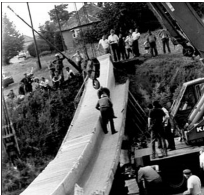
5. ábra: Herceghalom Preflex-tartós hídját magas jármű döntötte fel 1978-ban
