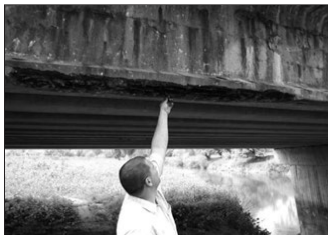
9. ábra: Körmened Rába-hídjának előregyártott gerendája súlyosan korrodálódott (2013.)
