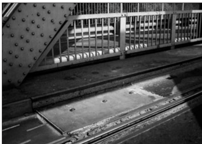
8. ábra: Baján az előregyártott pályalemez 1977-ben több helyen átszűrődött (a képen a javítás látható)
