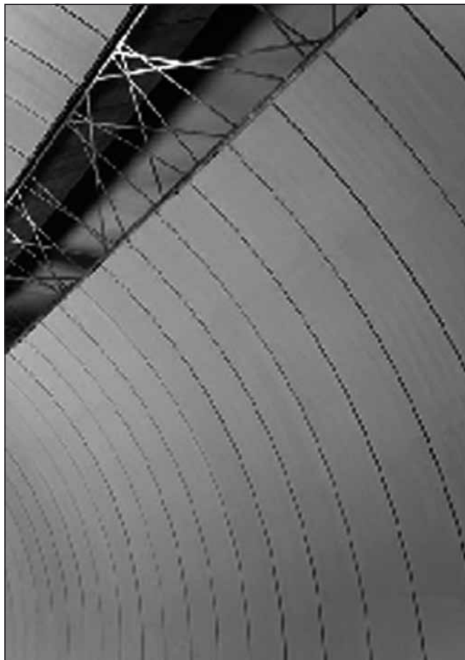
7. ábra: Beszerelt panelek az állomáson
