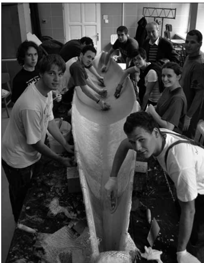
6. ábra: A betonréteg felhordásához sok szorgos kéz egyidejű és gondos munkája volt szükséges
