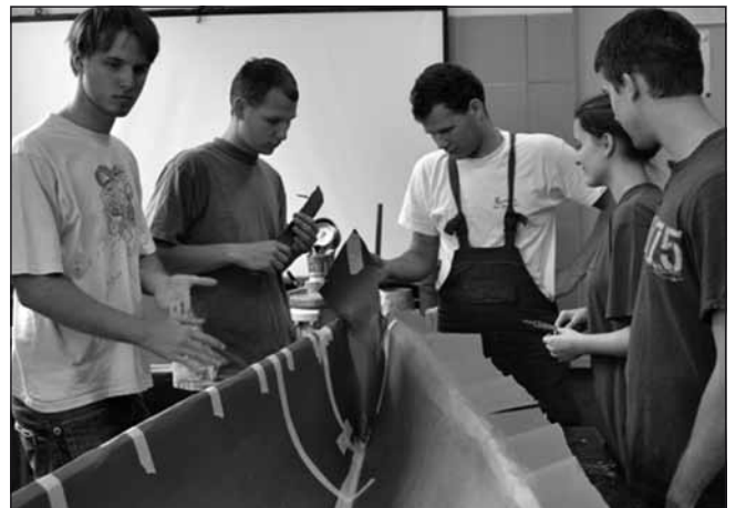
3. ábra: A zsaluleválasztó réteg elhelyezése
