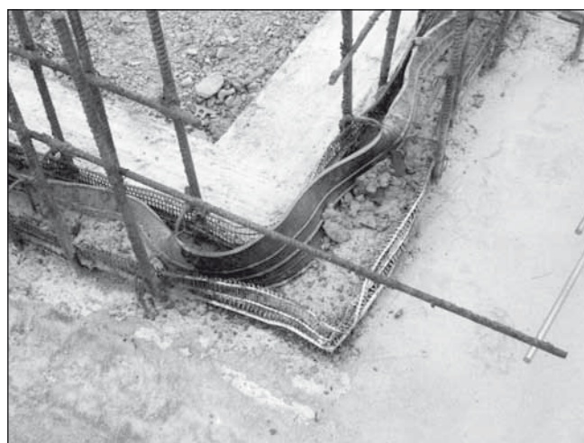
1. ábra: Bokafal nem megfelelő kialakítása következtében a vibrálásakor a beton nem maradt a „helyén”
