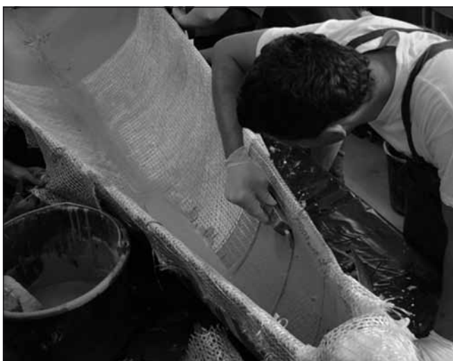
5. ábra: Betonréteg felhordása az üvegszövetre
