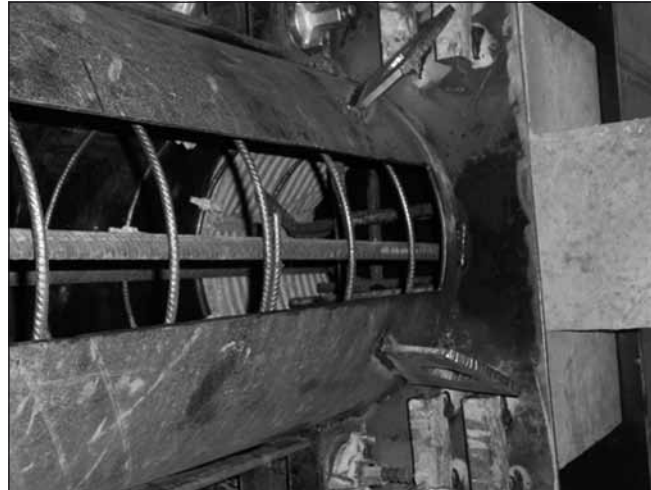
12. ábra: Fekve gyártás, a körzsalu felül 12 cm széles sávban nyitott
