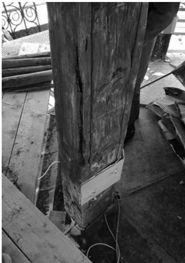
8. ábra: Károsodott ötszögletű oszlop a harangterasz szinten
