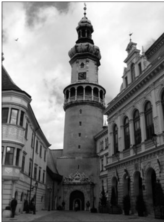
4. ábra: A Tűztorony a rekonstrukció előtt
