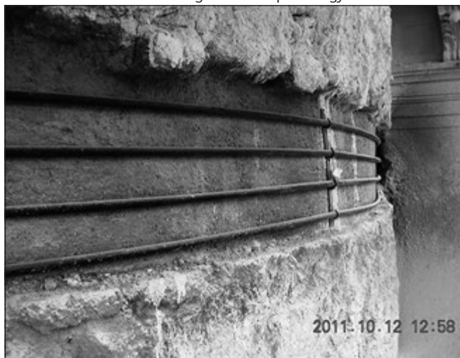
36. ábra: A lövellt betonkéreg és a feszítőpázsma gyűrűk
