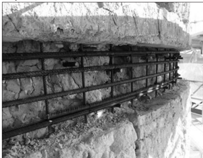
36. ábra: A lövellt betonkéreg és a feszítőpázsma gyűrűk
