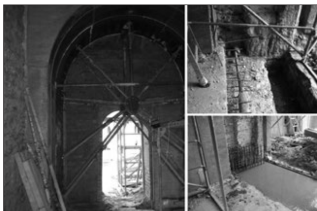
46. ábra: A vasbeton ívek építése, az ívek fémzszalagja
