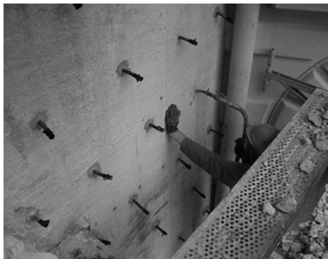
37. ábra: Injektáló csomók a Főtér felőli toronyfalán (Mingeo Kft, 2011)
