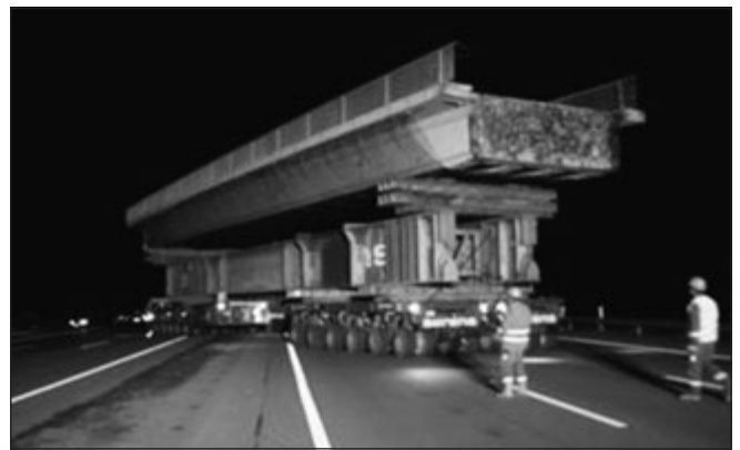
3. ábra: A Beckumi Hesseler-műemlék-híd áttelepítése (© www.eautobahn.de)
