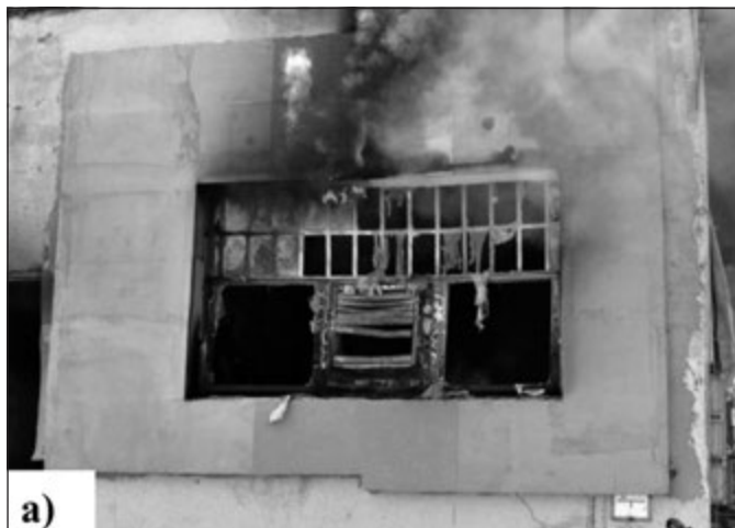
13. ábra: Az ablak környezetébe készített hőszigetelés, a) tűzterhelés közben, b) tűz eloltását követően, a vakolat eltávolítása során
