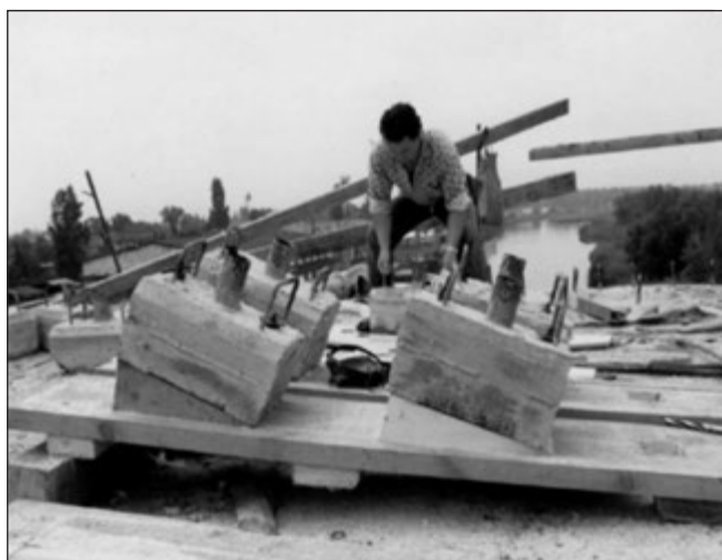
2. ábra: A feszítés lehorgonyzásaiba beépített előregyártott tömbök
