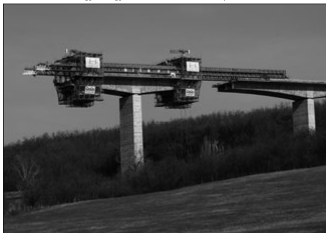
6. ábra: Kőröshegyi völgyhíd felszerkezetének építése
