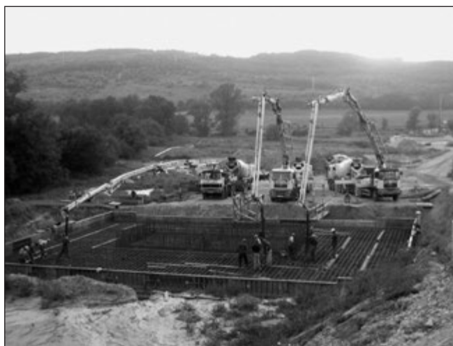
5. ábra: 1600 m 3 -es cölöpösszefogó gerenda építése
