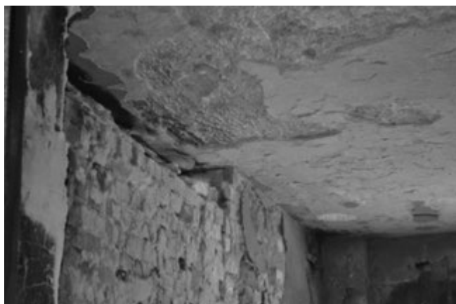
10. ábra: A betonfelület réteges leválása
