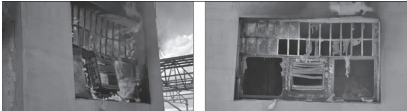
7. ábra: Az üveg kitörése és megfolyása a tűz hatására
