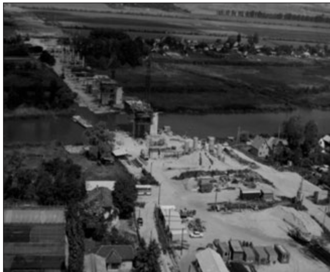
1. ábra: Soroksári-Duna híd telepített keverője
