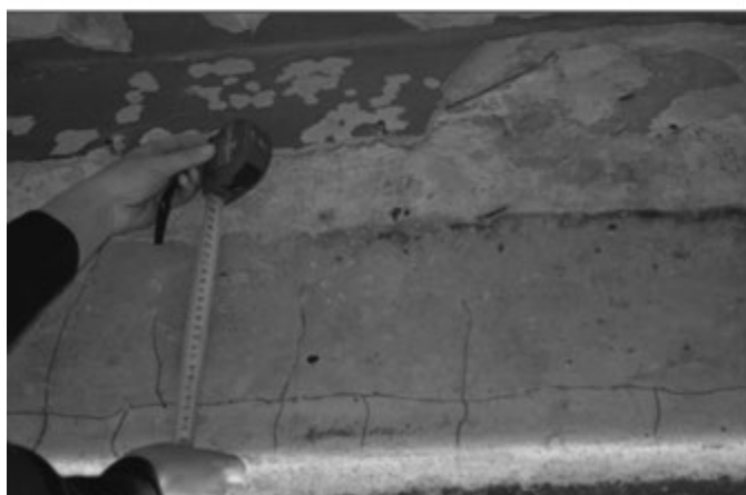
12. ábra: Az ablak fölötti áthidaló repedései
