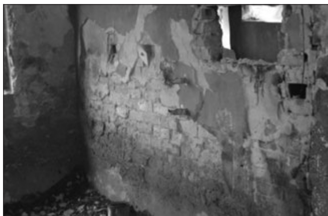
9. ábra: A kisméretű tömör téglafal a tűzvizsgálatot követően
