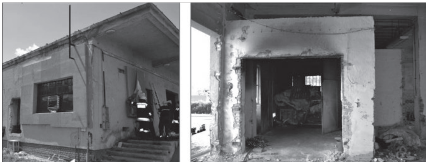
2. ábra: Tűzhatásra vizsgált csarnokrész homlokzatai (bal oldali kép) és belső térleválasztása (jobb oldali kép)
