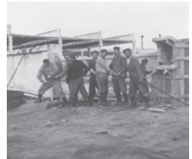
Hódmezővásárhelyi szaniterárú gyár utófeszített főtartói - feszítő huzalok betolása
