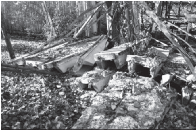
12. ábra: Stabilitásvesztéssel tönkrement vasbeton falpanel (bal oldali kép) és lemez (jobb oldali kép) (Testnevelési Egyetem tüzesete, 2015. okt. 15.)
