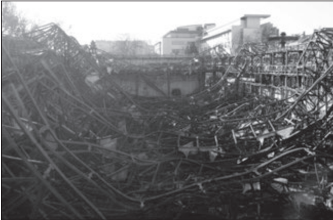
13. ábra: Az acél tetőszerkezet a tüzeset után (Testnevelési Egyetem tüzesete, 2015. okt. 15.)
