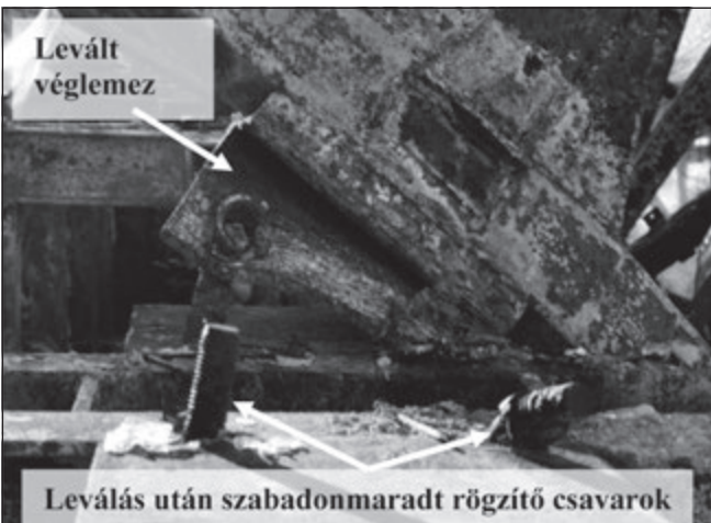
14. ábra: Az acél tartók véglemezeinek leválása a rögzítőelemekről (Testnevelési Egyetem tüzesete, 2015. okt. 15.)
