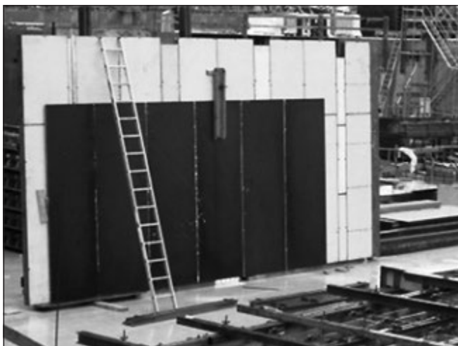
13. ábra: Zsaluzat beépítés előtt: látvány héjelemek felszerelése
