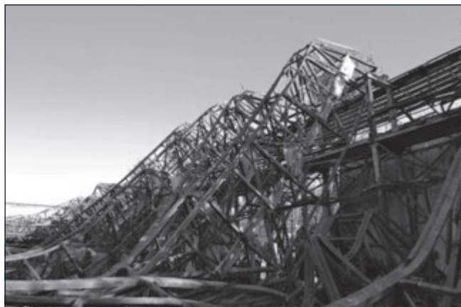
1. ábra: A beomlott acél tetőszerkezet a tűzeset után (Testnevelési Egyetem tűzesete, 2015. okt. 15.)
