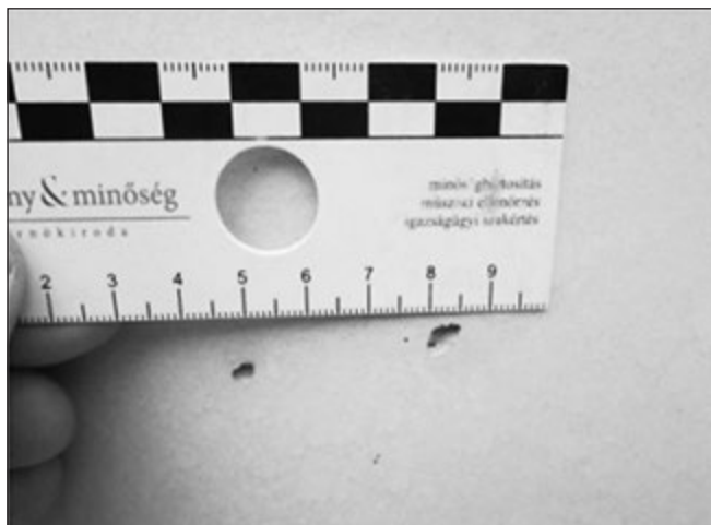
8. ábra: Tervezői követelmények megfogalmazása: a felületi buborékok számára és nagyságára vonatkozóan
