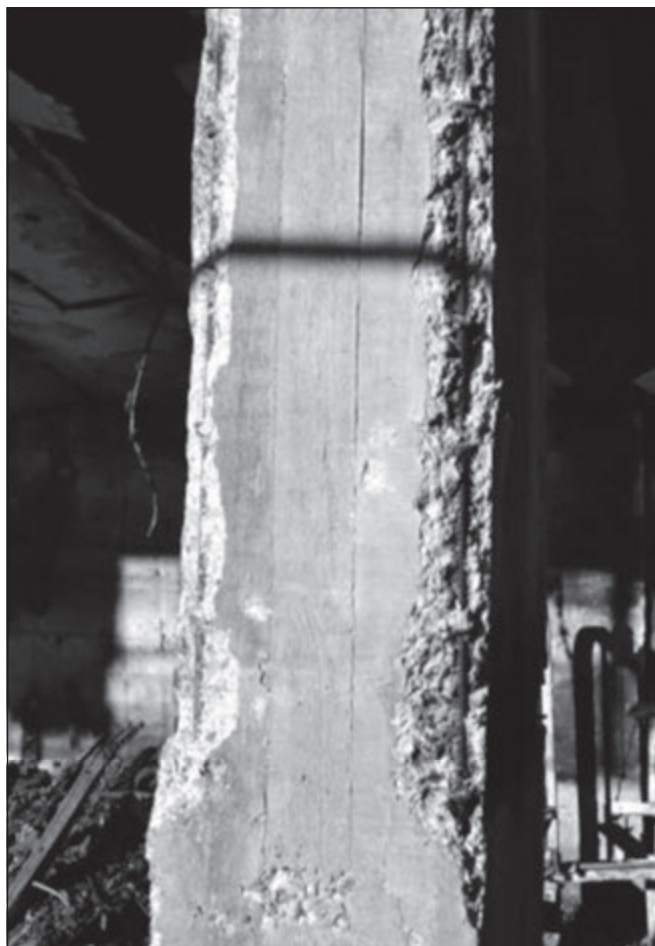
10. ábra: A betonfedés leválása a vasbeton pillér elein (Testnevelési Egyetem tüzesete, 2015. okt. 15.)
