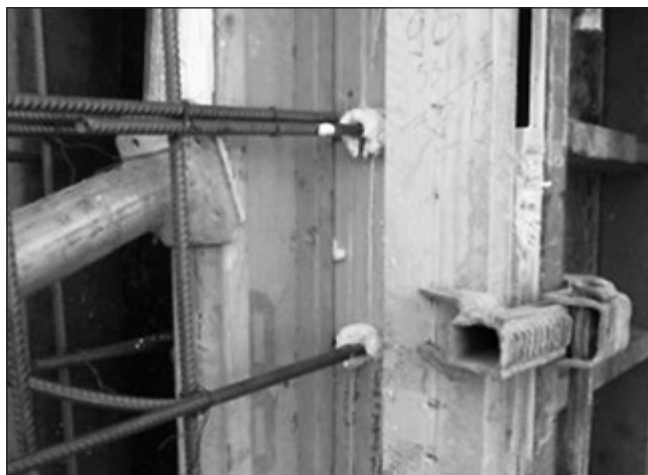
15. ábra: Zsaluzat betonozás előtt: munkahézagok tömítése
