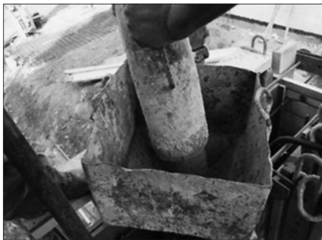
16. ábra: A beton szabadesésének korlátozása a zsaluzatok közé beengedett betonozó csővel
