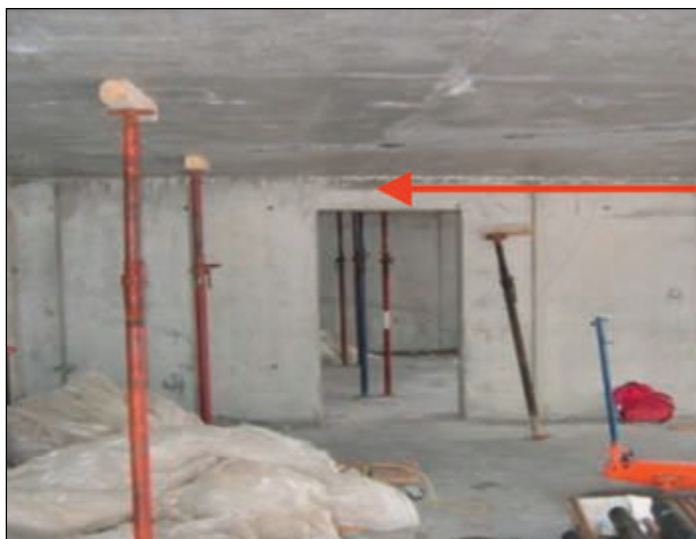
A csillapítók a gerendákat helyettesítik
