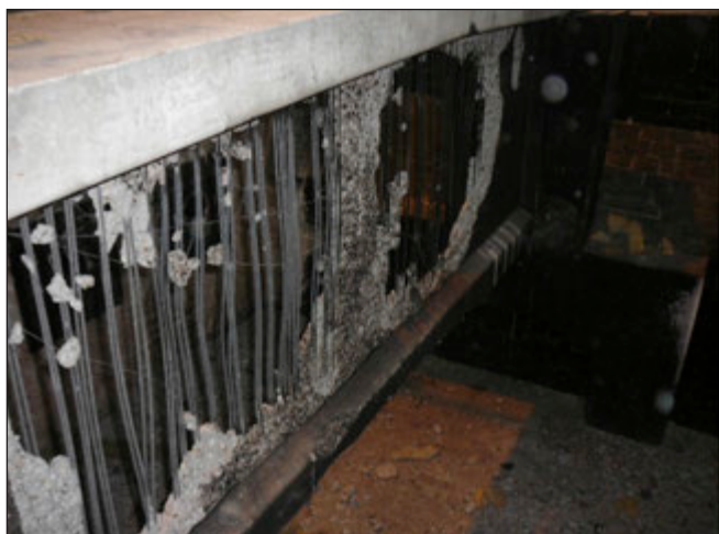
4. ábra: A betonfelület leválása egy gerendán
