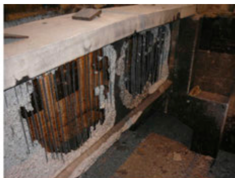
b) a betonfelület leválása
