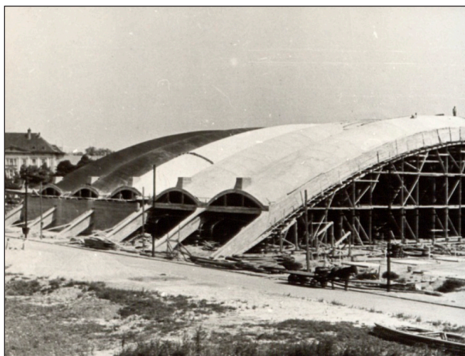
1. ábra: A garázs héjszerkezete építési állapotban (Foto: Menyhárd, 1942)
