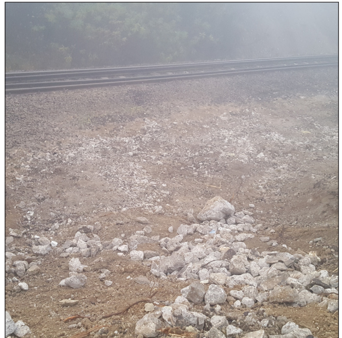
10. ábra: Az elbontott híd helye
