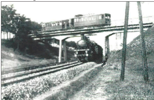
4. ábra: A még üzemelő híd oldalnézete
