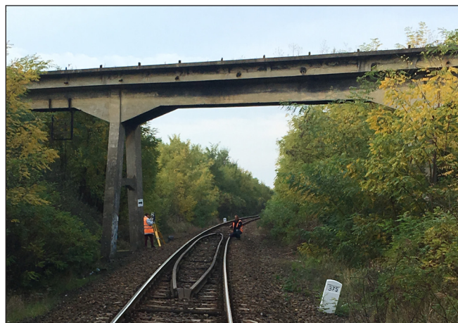
5. ábra: A bontásra ítélt 90 éves híd
