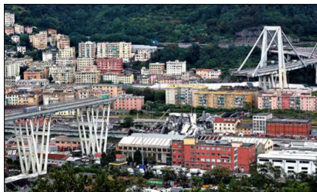
3. ábra: A Morandi híd az összeomlás után
