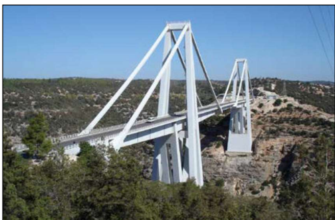
5. ábra: Morandi Wadi al Kuf viaduktja Líbiában
