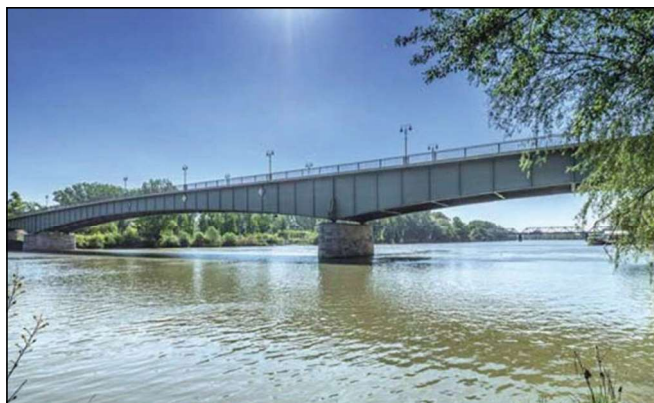
3. ábra: A tokaji Tisza-híd
