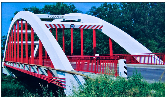
10. ábra: A tiszalöki Keleti-főcsatorna-híd
