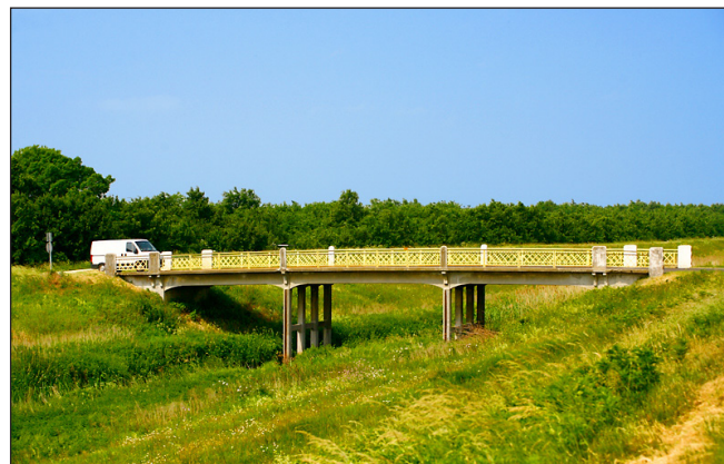
4. ábra: Rábakecöl Répce-árapasztócsatorna hídja
