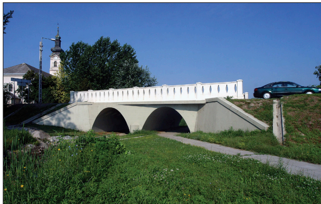
1. ábra: A solti vasbeton boltozatú csatorna híd
