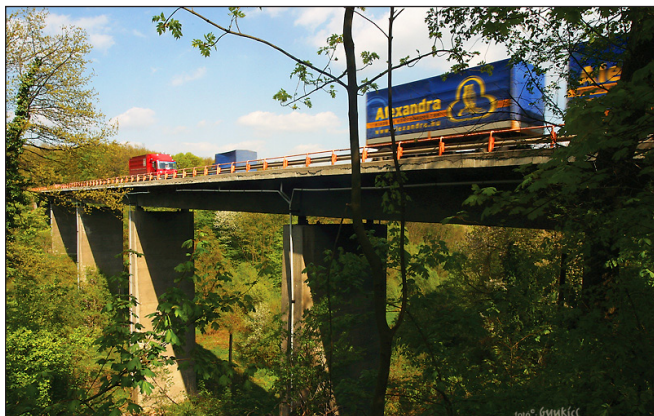
9. ábra: A Bolondúti völgyhíd
