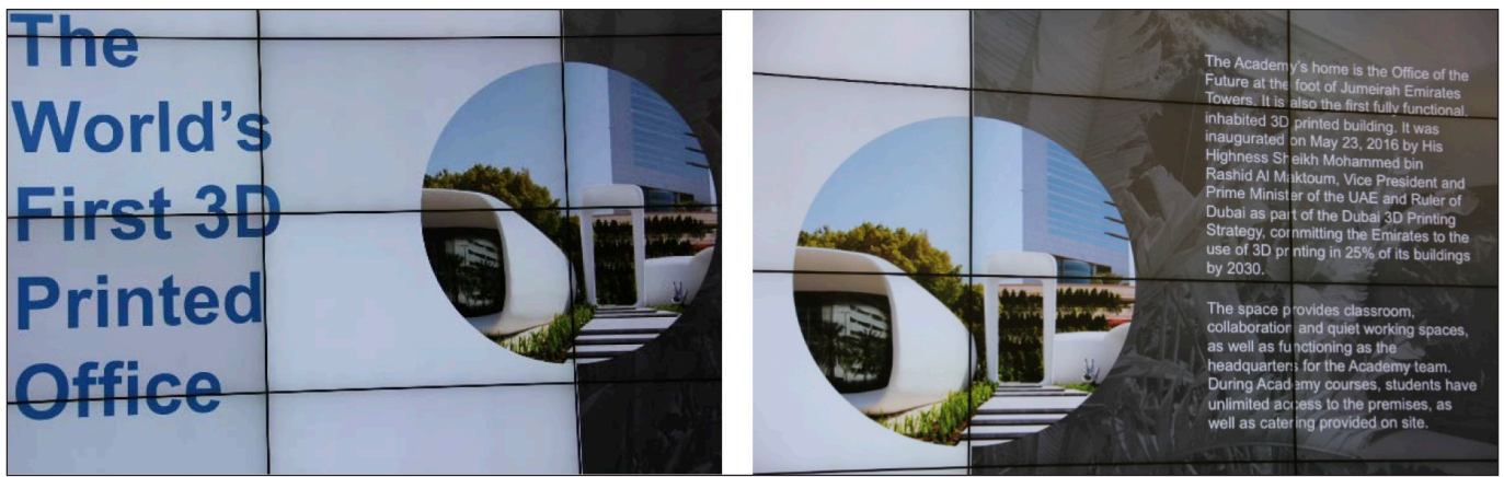
1. ábra: A világ első 3D betonnyomtatással készült irodaépülete Dubaiban (UAE), megnyílt: 2016. május 23-án
