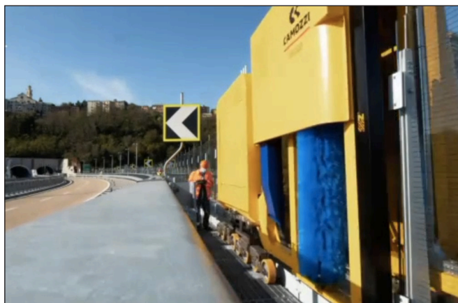
10. ábra: Ellenőrző robot a híd sínrendszerén
