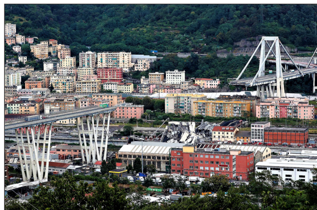
2. ábra: A Morandi-híd az összeomlás után, Genova
