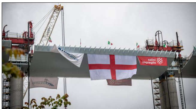
16. ábra: Az épülő új viadukt első darabja
