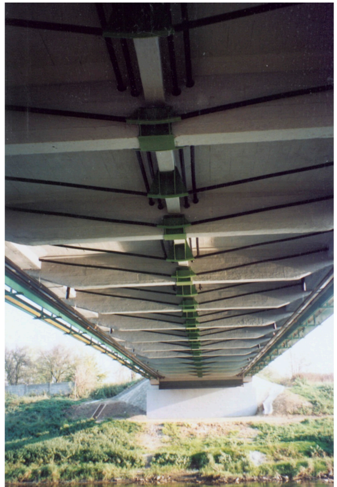
2.ábra: A sárvári Rába-híd pályaszerkezetének megerősítése külsőkábelekkel
