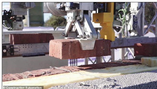
6. ábra: Új téglalor építése (Construction Automation, 2020)
