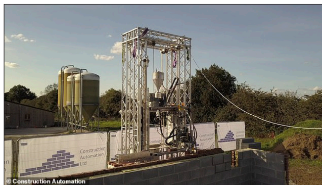
5. ábra: A Construction Automation Ltd. falazó robotja munka közben (Construction Automation, 2020)
