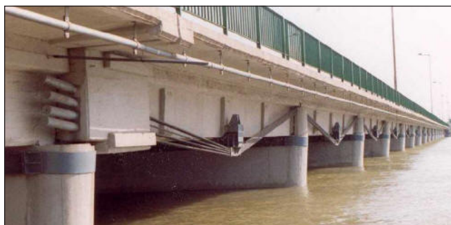
Utófesztéssel megmentett szolnoki Tisza-ártéri-híd
