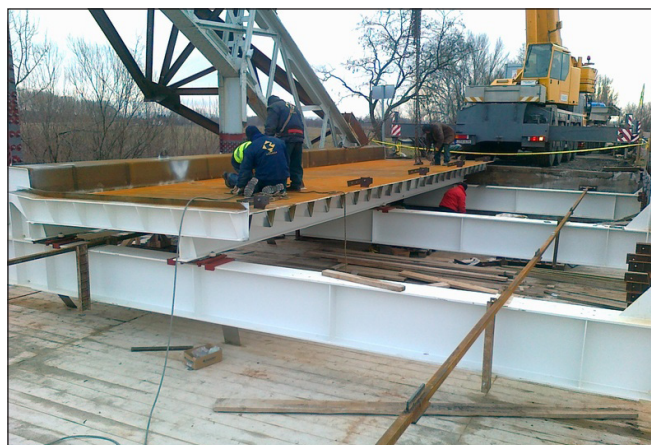
Marcaltói Rába-híd átépítése
