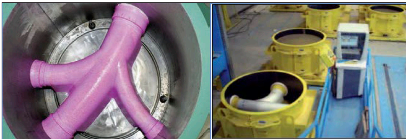
3-4. ábra: A mágnessel rögzített negatív forma körbeöntése öntömörödő betonnal [fotók: Spránitz]
