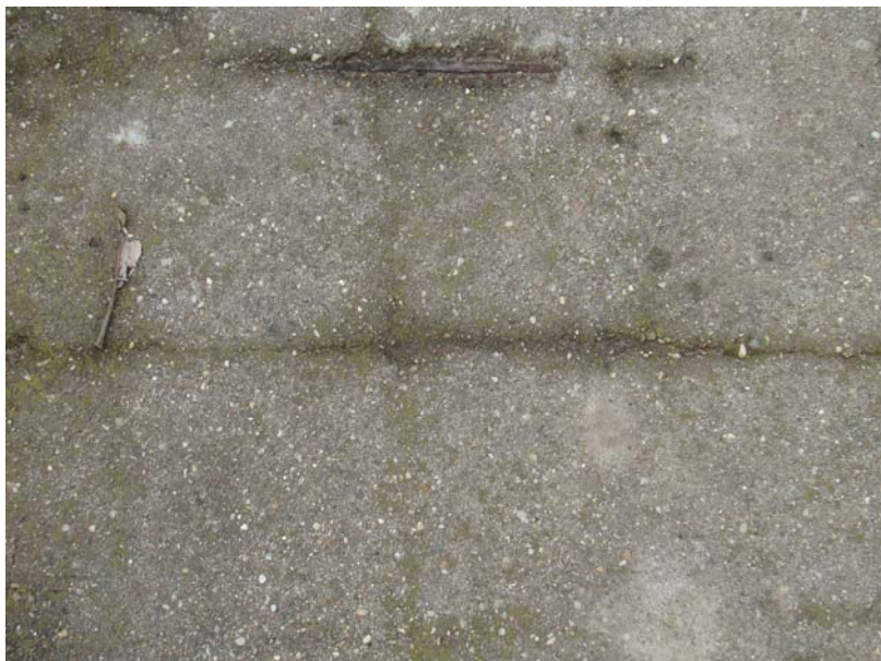
3. fotó : Helyenként az acélbetét túl kicsi fedettségű, a habarcs kitöredezett, az acél rozsdás
