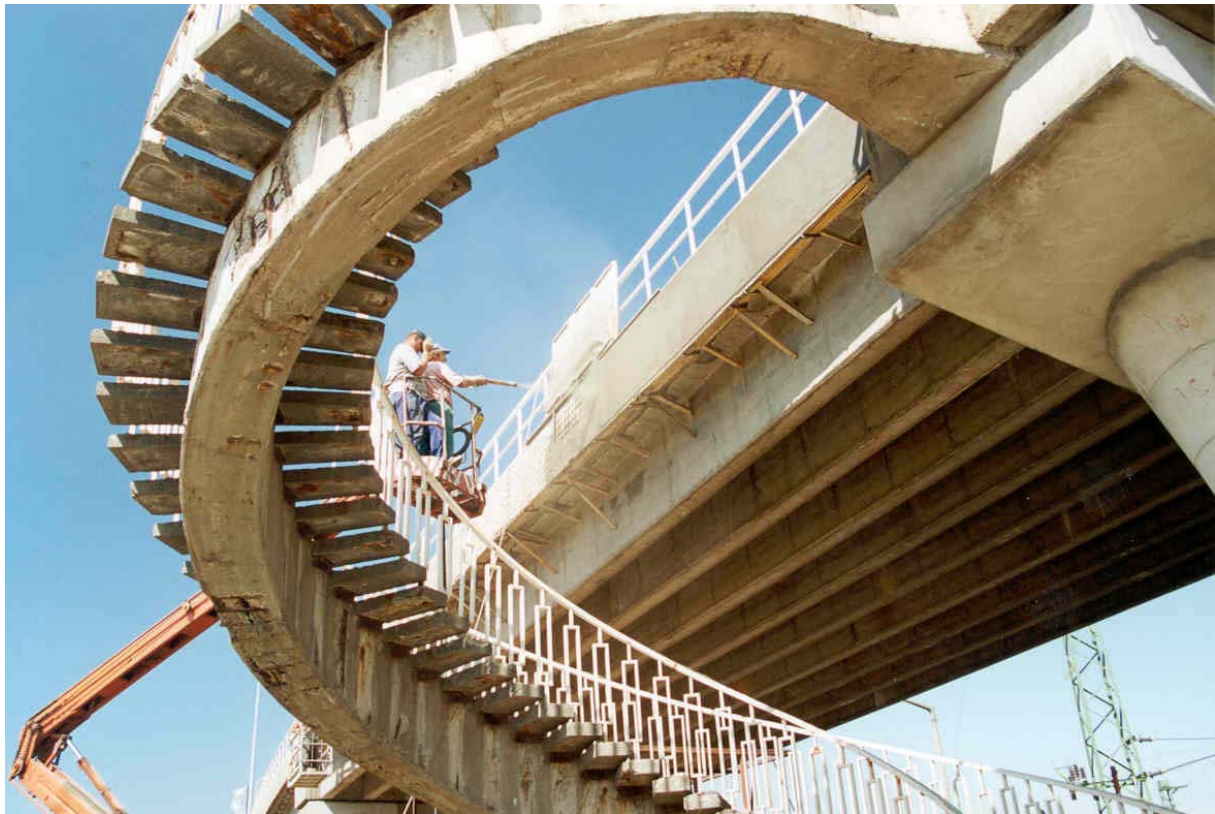
12. ábra: A sózás hatása a felüljárók környezetében
