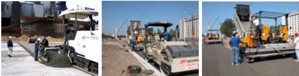
1-3. kép: Aszfaltfiniseres terítéssel és azonnali úthengeres tömörítéssel készülő betonburkolat („Rolling Compact Concrete Pavement” – RCCP)
