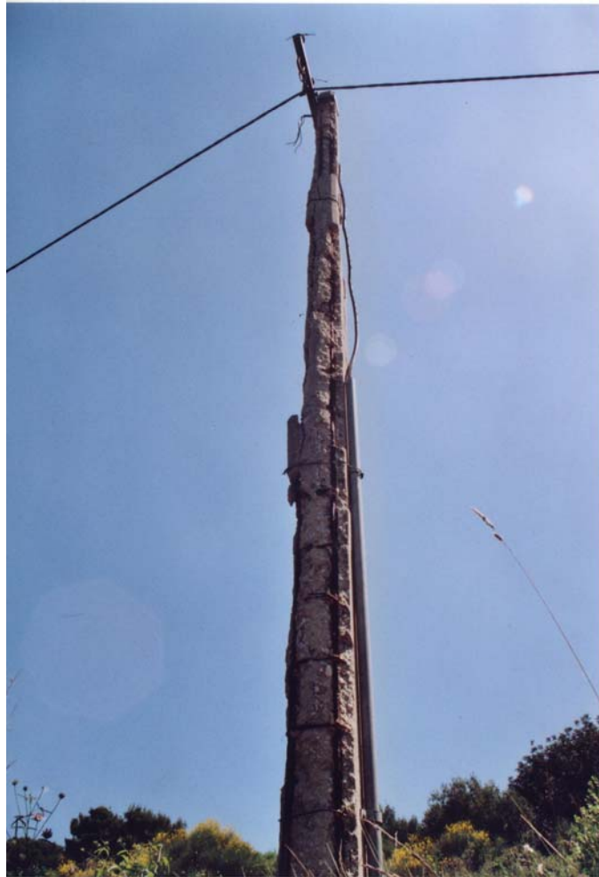
2. ábra: A horvát tengerpart sós és nedves levegőjétől leromlott vasbeton villanyoszlop
