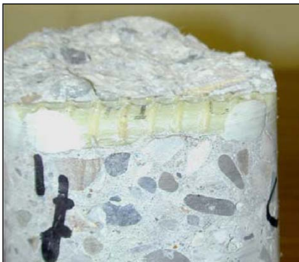
19. ábra: Kifűrt magminta GFRP betéttel
