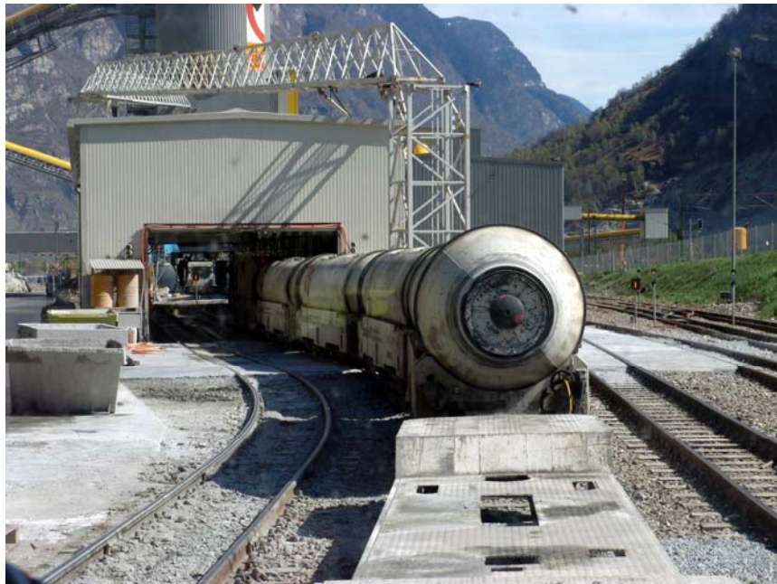
2. ábra: A beton szállítását biztosító vasúti mobil mixerek képe az új Gotthard vasúti alagút építésénél (fotó: www.alptransit.ch honlapról)
