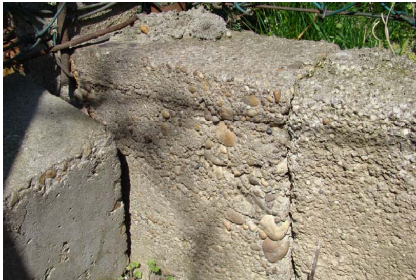
5. fotó : A csatlakozásoknál nagy zsugorodási hézagok keletkeztek
