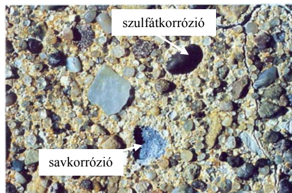
4. ábra: Beton biogén kénsavas korróziója (Bielecki et al., 1987)
