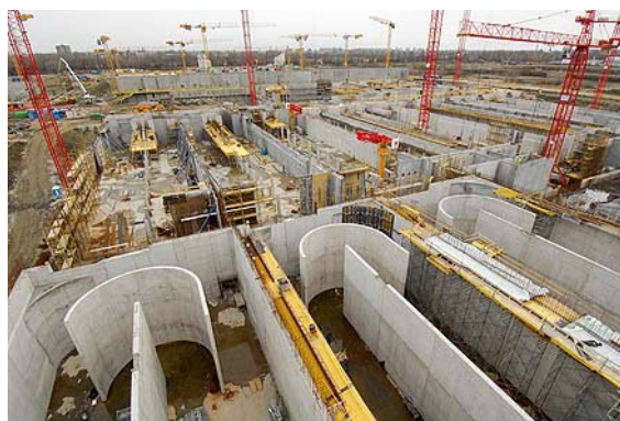
11. ábra: Budapesti Központi Szennyvíztisztító Telep építés közben (fényképezte: Vanik Zoltán)
