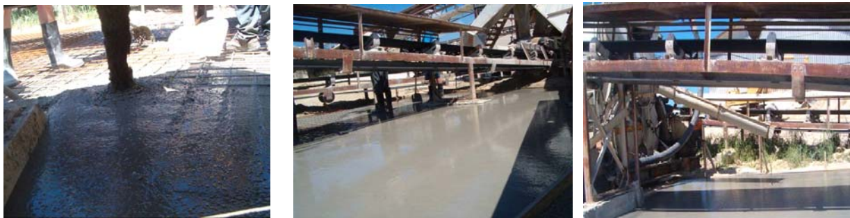
7-9. kép: Sík betonburkolat készítése nehezen hozzáférhető helyen öntömörödő betonnal
