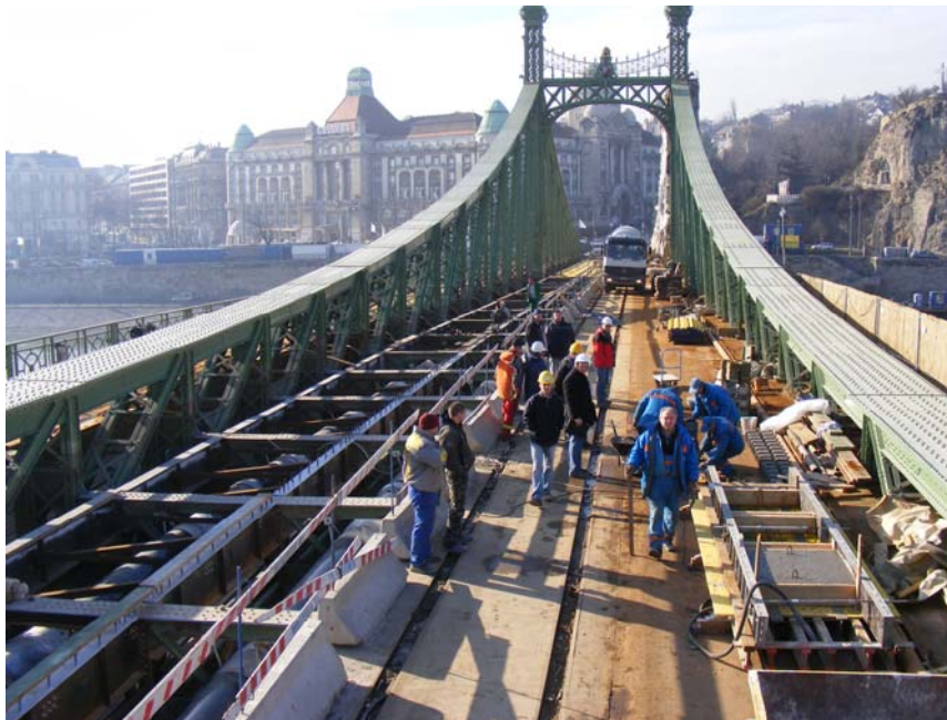
4. ábra: A budapesti Szabadság-híd épülő pályaszerkezete (fotó: Tóth László)
