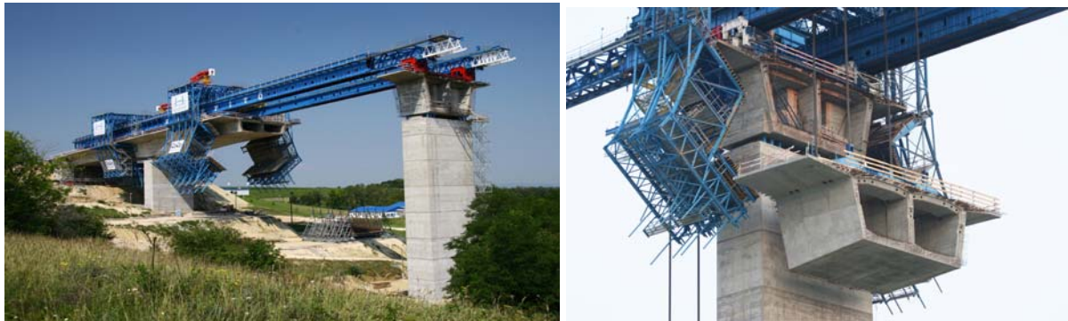
7. ábra: Kőröshegyi völgyhíd építése
