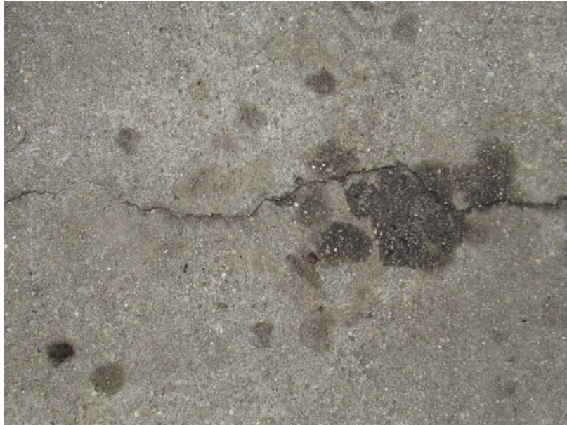
2. fotó : A záróhabarcs on a vizsgálatkor elhajlított panel repedése jól kirajzolódik
