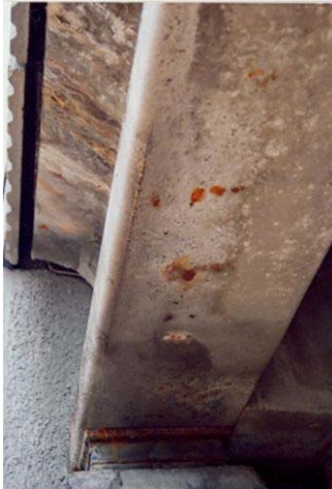
10. ábra: A hídszegély és a szélsőtartó korróziója
