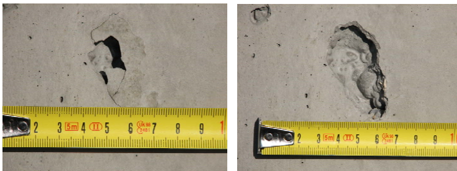
13. ábra: Korróziós hibahelyek a beton felületén (bal oldalon: vékony cementpéppel eltakart tömörítési hiányosság, jobb oldalon: ugyanazon tömörítési hiányosság a vékony cementpép eltávolítása után)
