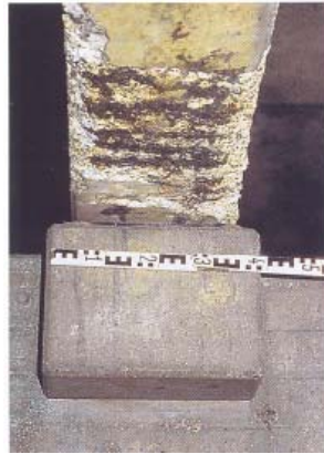
6. ábra: Betonkárosodás szennyvízcsatorna kéntartalmú gázainak hatására (Dorner, 2000)
