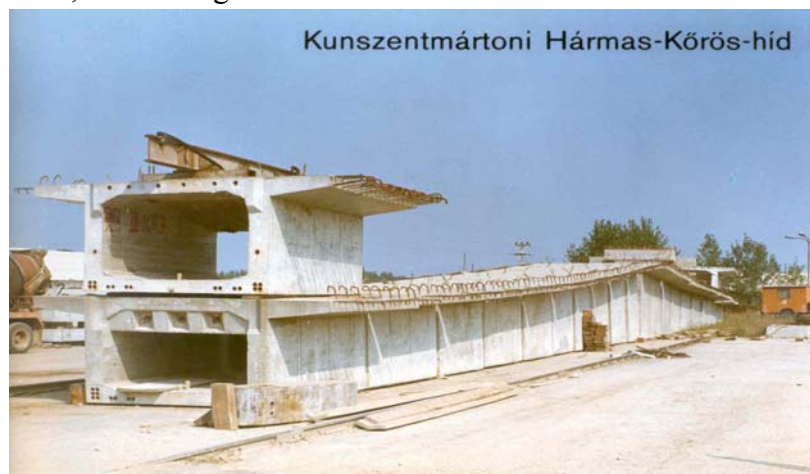
3. ábra: Kunszentmártoni Hármaskörös-híd előregyártott elemei
