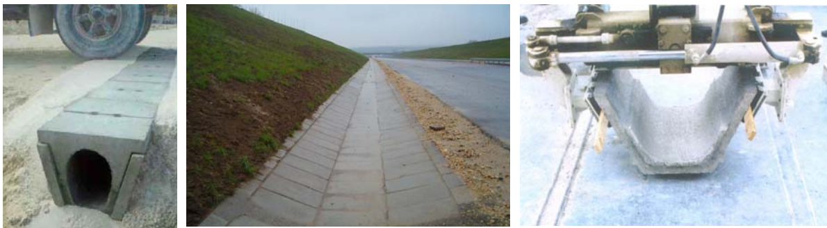
16-18. kép: A 60-160 \text{ g/m}^2 fagyhámlási értékű, tehát az XF 4 kitéti osztálynak megfelelő, nagy hajlítószilárdságú betontermékek 310 \text{ kg/m}^3 cementtartalommal
