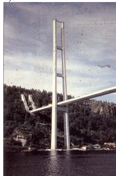
4. ábra: Stovset híd (fib, 2000)
