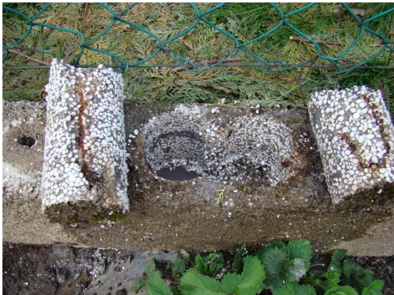
9. fotó : A csekély fedettségű betétek rozsdásak, és elkülönültek a beton mátrixtól
