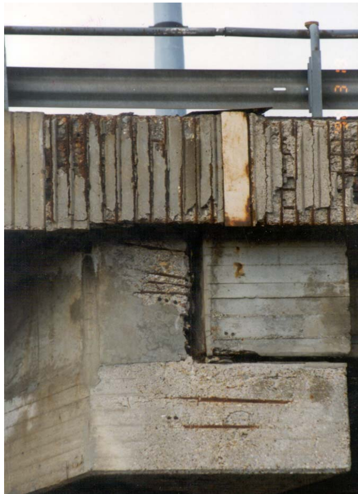
11. ábra: A dilatáció helytelen elhelyezése
