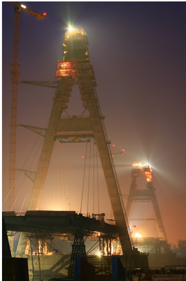
5. ábra: A budapesti M0 autópálya épülő északi Duna-hídja (fotó: Hídépítő Zrt.)
