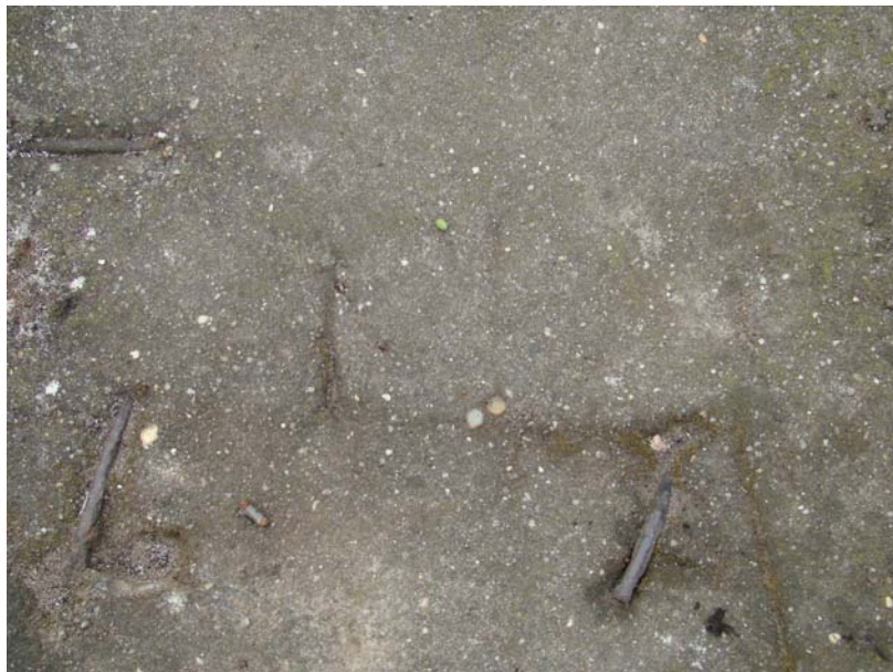
1. fotó: A panelek záróhabarcsa jó állapotú, helyenként a távtartó acélok a felületre kerültek
