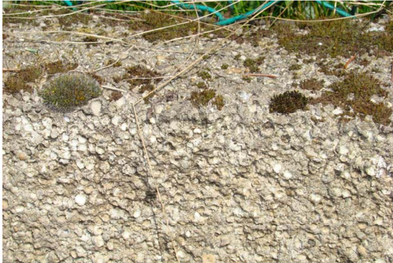
4. fotó : A szabadban elhelyezett panel felületéről a szemcsék lemállottak
