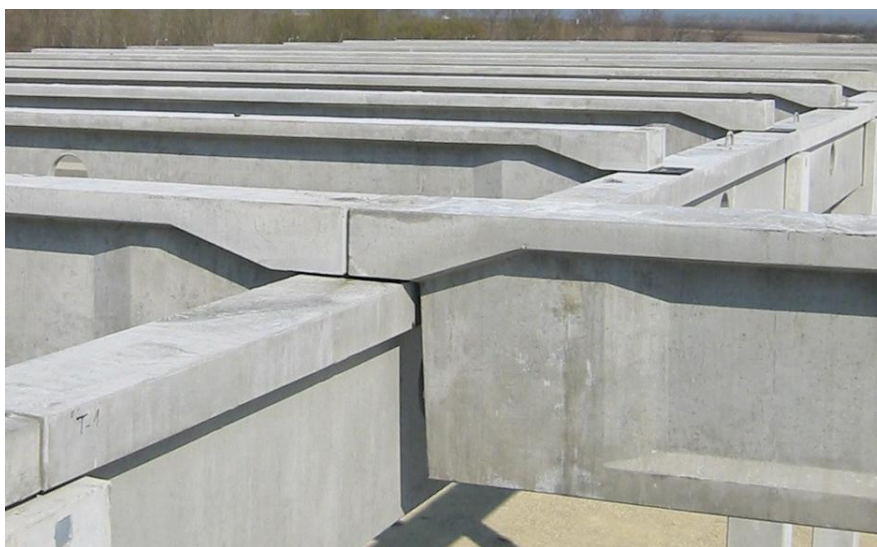
Fig. 9 Precast elements for a hall (Photo: András Leidál)
