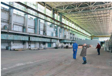
1.ábra A 90 éves Lőke Endre 2012-ben örömmel szemléli a most már több, mint 50 éve tervezett és megvalósult kompresszor csarnok utófeszített vasbeton tartóit
