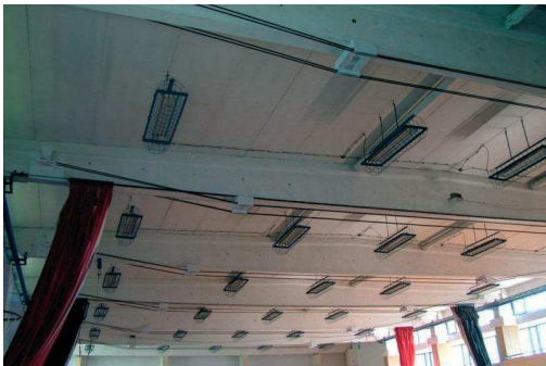
12. ábra. Sportszarnok vasbeton főtartóinak megerősítése
