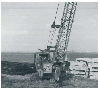
4. ábra A főtartó elemei a földön, fekvő állapotban, mellette a láncalpas 5 tonna teherbírású daru, a sárban
