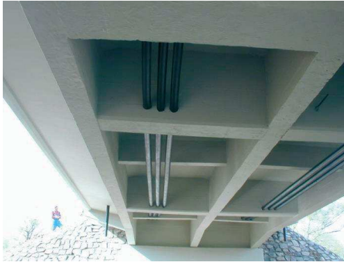
3. ábra. Múemléki híd megerősítése utólagos feszítéssel
