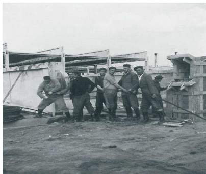
5. ábra Feszítő huzalok behúzása a kábelüregbe
