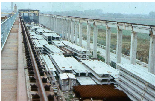
7. ábra TT födémek a 31 sz ÁÉV hódmezővásárhelyi üzemében, 1976.
