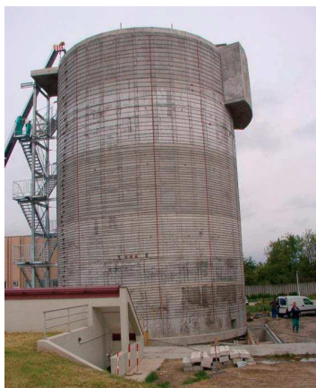
15. ábra. Iszaprohasztó tartály megerősítése
