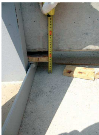
A tartó elemelkedése a támaszról az utolsó kábel feszítését követően
