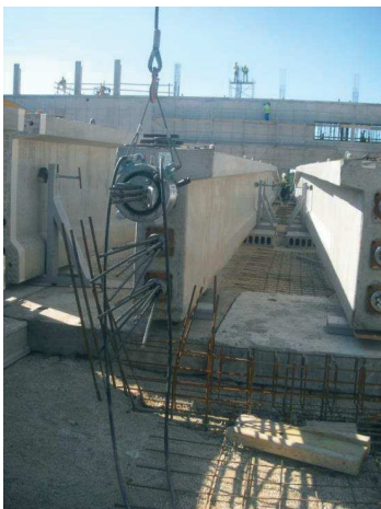
Az első kábel részleges feszítése
