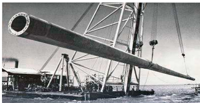
2. ábra feszített cölöp beemelése
