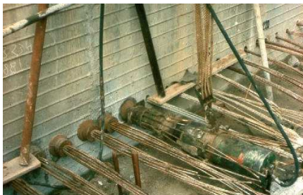
9. ábra Lemez feszítése Freyssinet sajtóval
