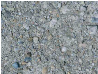
2/a ábra 2005-ben CEM I 32,5 N-S cementtel készült takarmánytároló állapota 2010-ben (fényképezte: Kovács József DDC Kft.)
