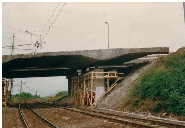
10. ábra. A 446-os út vasút feletti hídja
