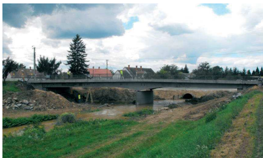
7. ábra. A Kerka híd megerősítése
