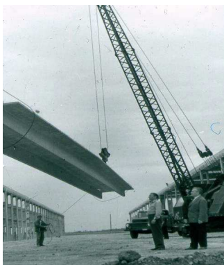
6. ábra 1969. Az Edénygyár építése
