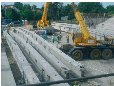
Siófoki Sportszarnok: az építés helyszíne
