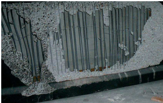
2. ábra A betonfelületek robbanásszerű leválása tűzhatás során (Balázs, Lubláy, 2008)
