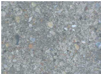
2/b ábra 2005-ben CEM III/B 32,5 N-S cementtel készült takarmánytároló állapota 2010-ben (fényképezte: Kovács József DDC Kft.)
