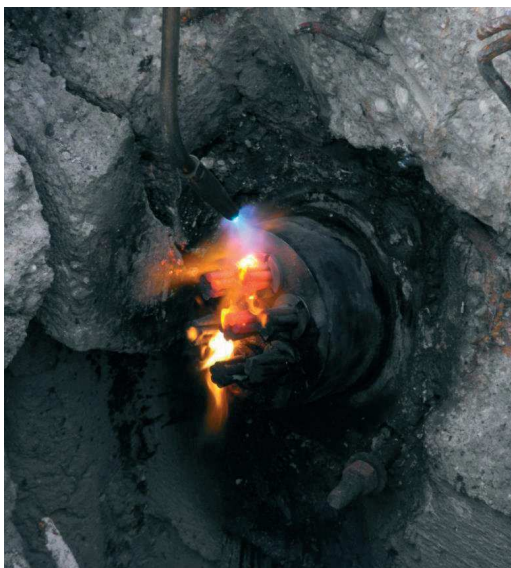
9. ábra. A Kerka híd feszítőkábel lehorgonyzásának elbontása
