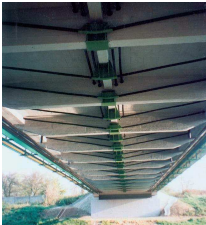
5. ábra. A sárvári Rába híd megerősítése.
