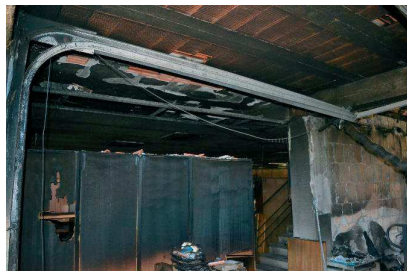
3. ábra Tűzkárt szenvedett épület belsejében a különböző mértékben károsodott anyagok (Balázs, Lublóy, Czoboly, 2014)
