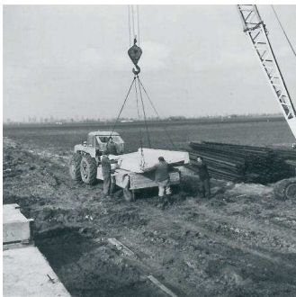
3. ábra A 18 m fesztávú főtartó 4,5 m hosszú elemének levétele a traktor vontatta pótkocsiról
