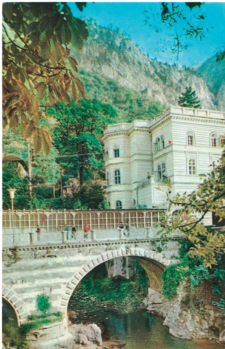
9. ábra. A híd kifolyási oldala a volt Ferenc József udvarral. Képeslap 1963-ból
