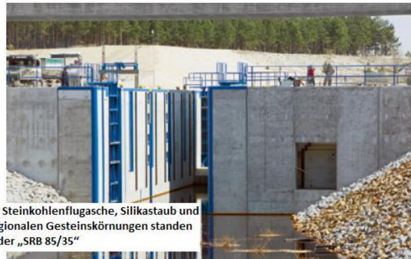
Bild 6: Sicht in Schleusenammer von der Seite Partwitzer See
